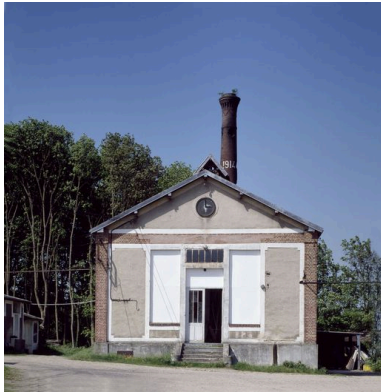
Chaufferie : élévation antérieure. Phot. Patrick Glotain IVR22_19936001826XA
