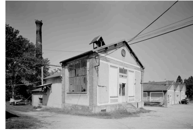
La chaufferie avec sa cheminée et les ateliers en shed à l'arrière plan. Phot. Patrick Glotain IVR22_19936000713V
