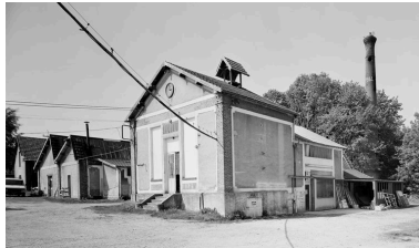
Chaufferie : élévation antérieure. Phot. Patrick Glotain IVR22_19936000710V
