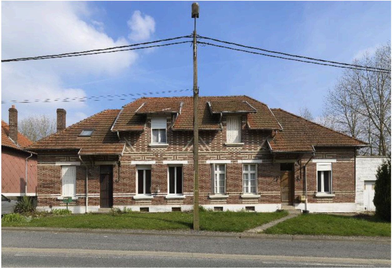
Maison à deux logements (21-22, rue de Roisel).
