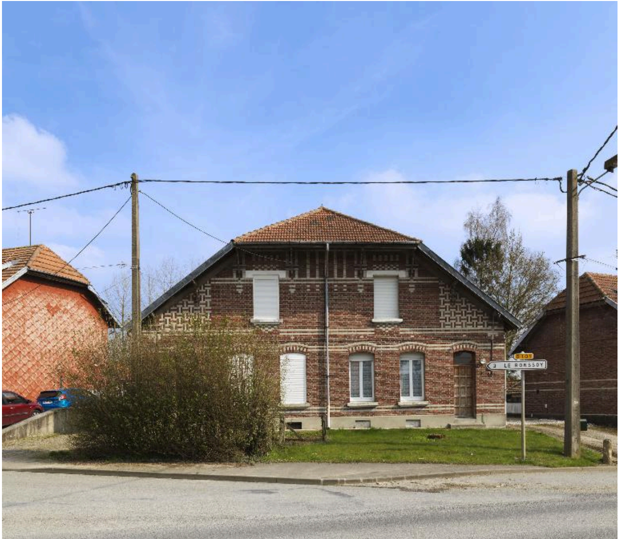
Maison à deux logements.
