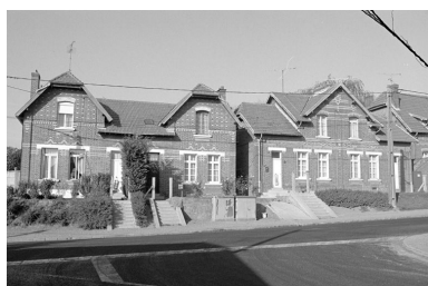
Logement d'ouvriers, vue partielle. Phot. Francis Dubuc IVR22_19908001254Z
