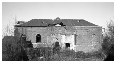
Elévation arrière de l'atelier de fabrication. Phot. Thierry Lefébure IVR22_19950203297X
