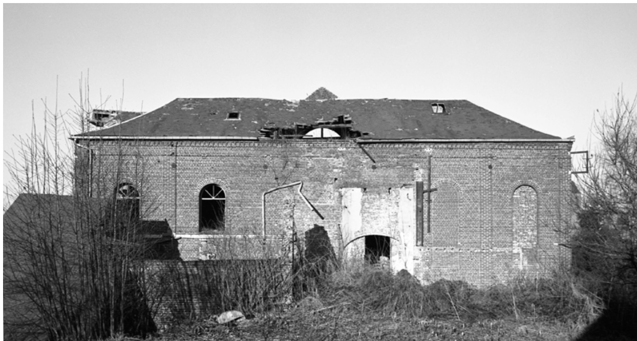
Elévation arrière de l'atelier de fabrication.
