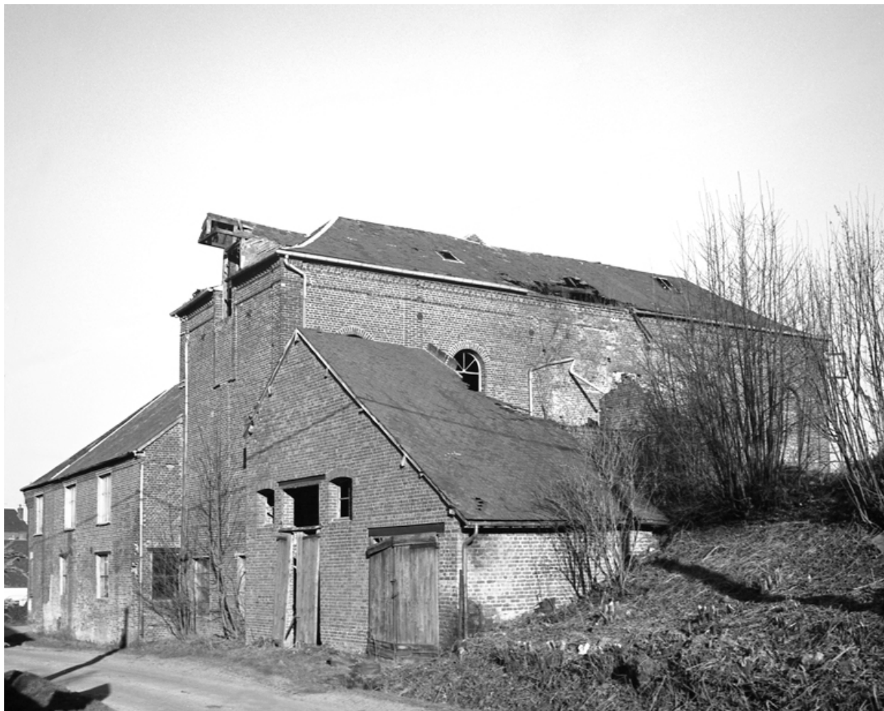
Vue générale de l'usine, prise depuis le sud-ouest.
