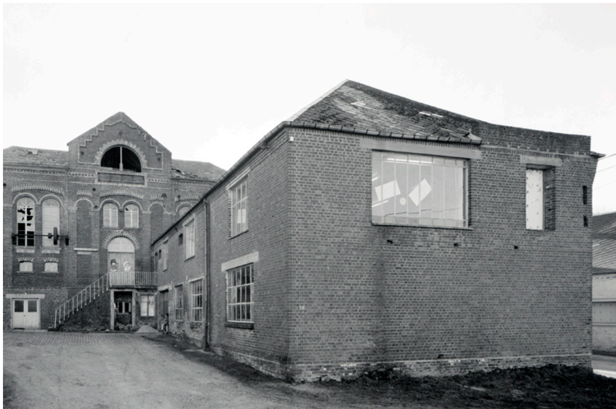
Vue générale de l'usine, depuis l'entrée.
