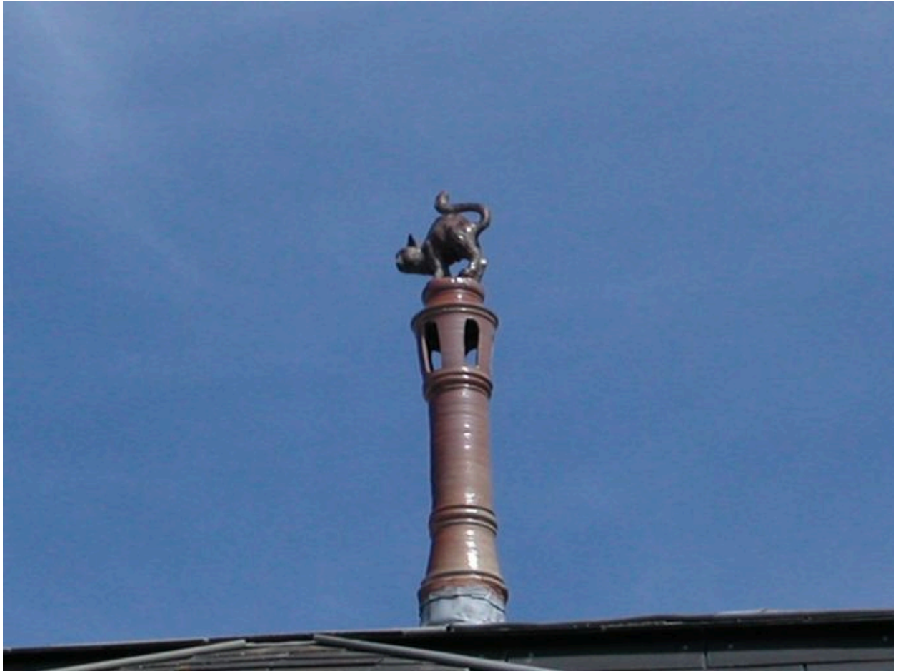
Détail du chat en céramique situé sur le toit de la maison implantée à l'aplomb de la rue.
