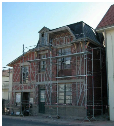
Vue d'ensemble de la maison principale en cours de restauration, 2003. Phot. Elisabeth Justome IVR22_20058003967NUCA
