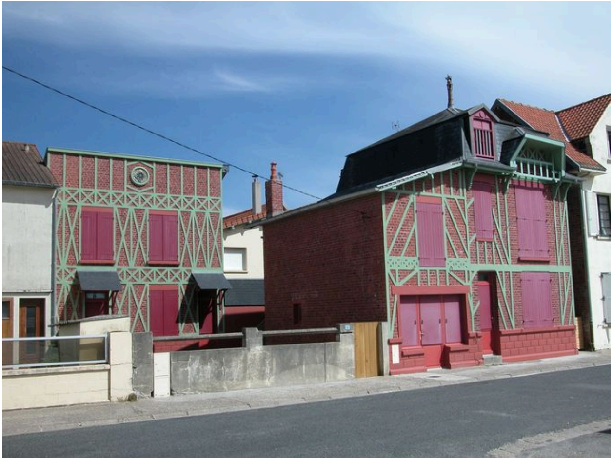
Vue d'ensemble des deux habitations, après restauration.
