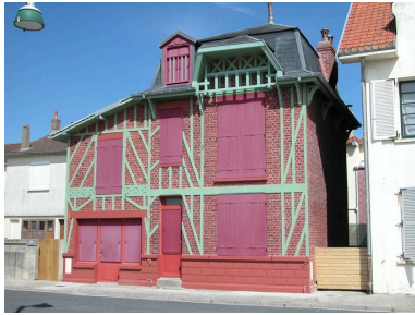
Vue d'ensemble de la maison principale, après restauration. Phot. Elisabeth Justome IVR22_20058003970NUCA
