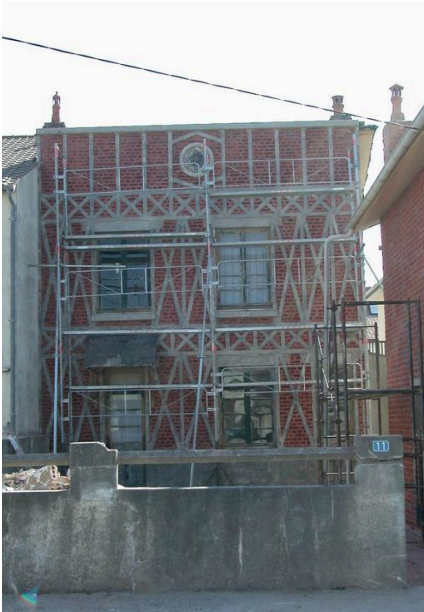
Vue d'ensemble de la maison située en fond de parcelle en cours de restauration, 2003.
