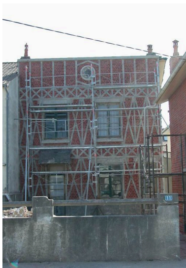
Vue d'ensemble de la maison située en fond de parcelle en cours de restauration, 2003. Phot. Elisabeth Justome IVR22_20058003968NUCA
