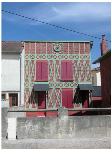
Vue d'ensemble de la maison située en fond de parcelle, après restauration. Phot. Elisabeth Justome IVR22_20058003971NUCA
