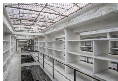
Bâtiment du dépôt, troisième étage : vue du vaisseau 2 vers l'est. Phot. Pierre Thibaut IVR31_20155901866NUCA
