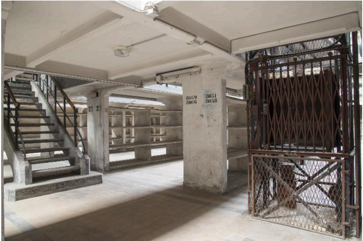
Bâtiment du dépôt, rez-de-chaussée : vue des vaisseaux 1 et 2, monte-charge et départ de l'escalier.
