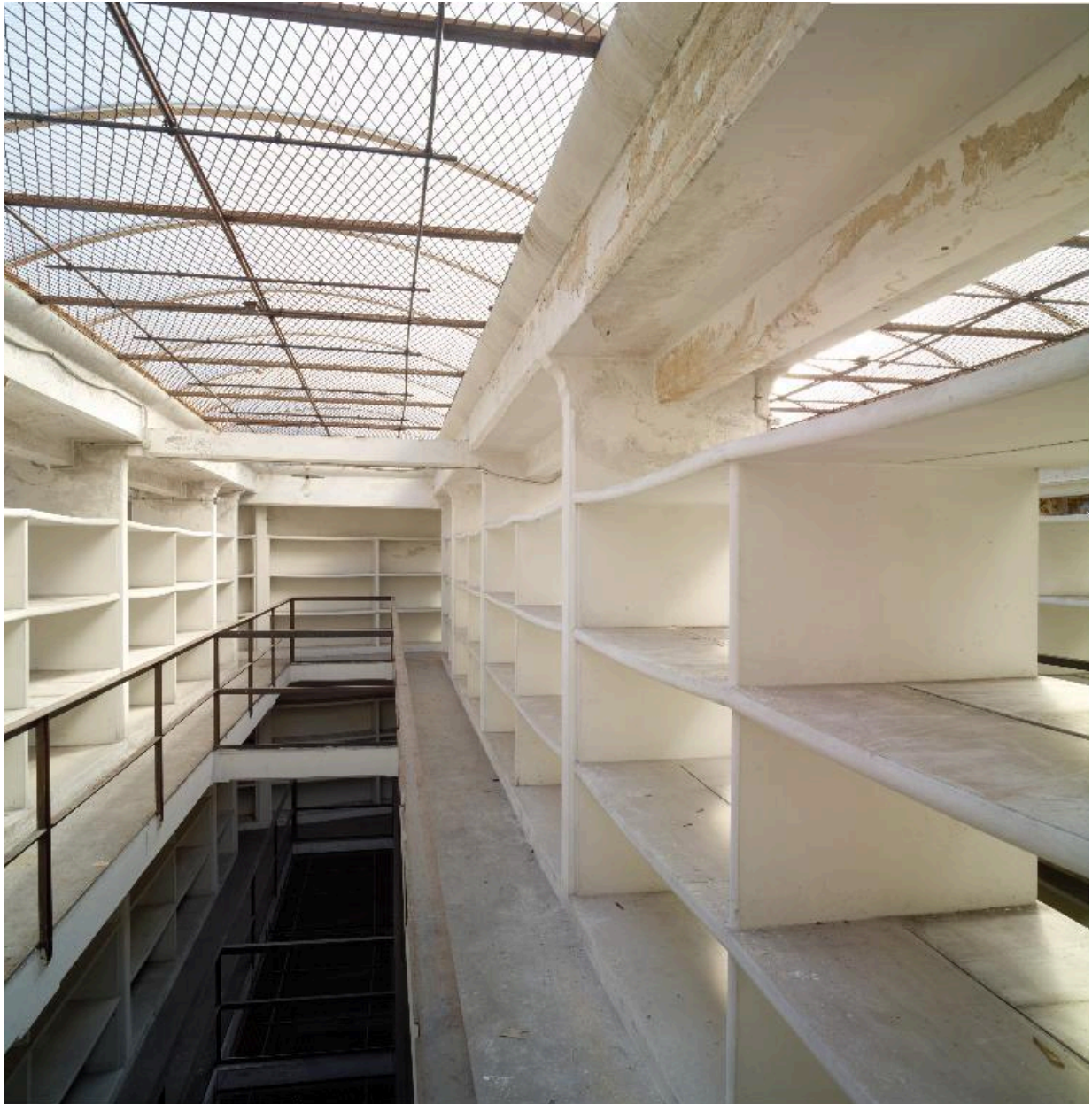
Bâtiment du dépôt, troisième étage : vue du vaisseau 2 vers l'est.
