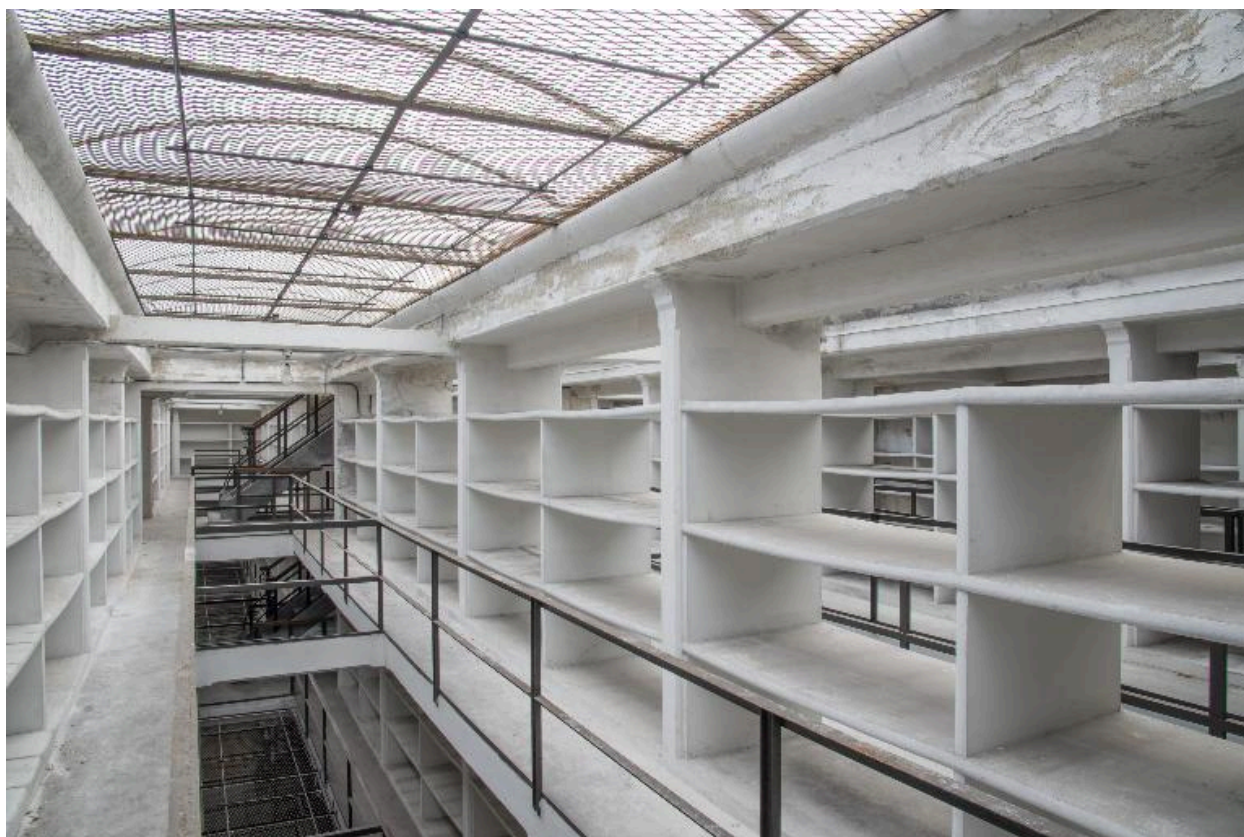
Bâtiment du dépôt, troisième étage : vue du vaisseau 2 vers l'est.
