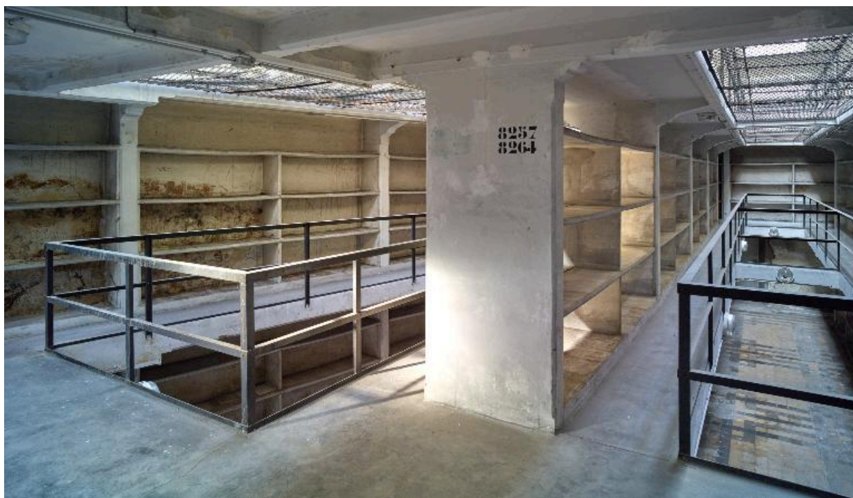
Bâtiment du dépôt, premier étage : vue des vaisseaux 3 et 4, vers l'ouest.
