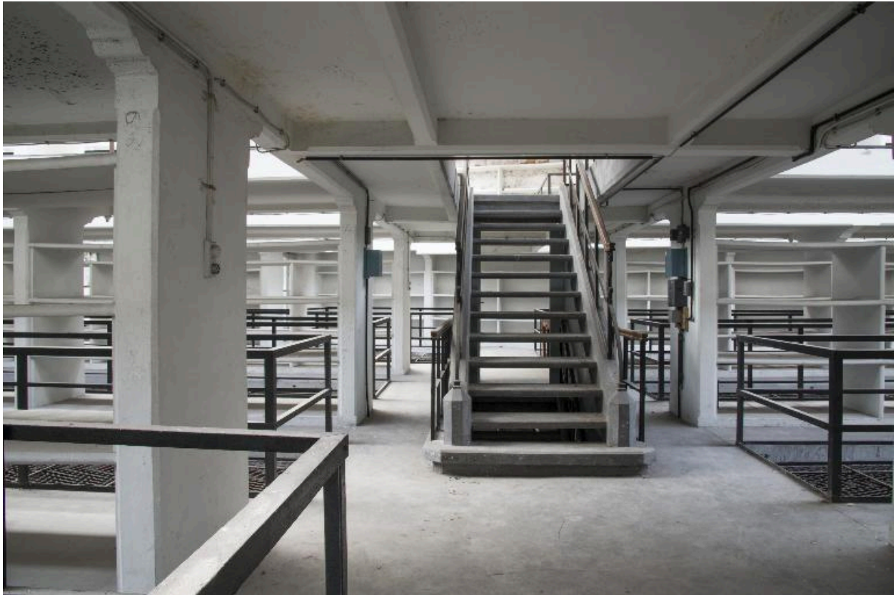
Bâtiment du dépôt, deuxième étage : vue du palier et départ de l'escalier.
