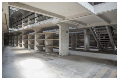
Bâtiment du dépôt, rez-de-chaussée : vue de l'extrémité ouest du vaisseau 4 et dessous de l'escalier. Phot. Pierre Thibaut IVR31_20155901883NUCA
