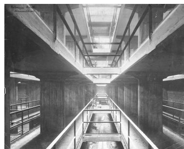
Intérieur du bâtiment du dépôt en chantier : vue du vaisseau 2 depuis le premier étage, côté est. On remarque à droite le mur nord en brique. Photographie (IFA ; 076 Ifa 108/10 : 2-C-048).
