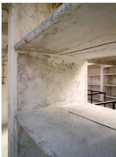
Bâtiment du dépôt, troisième étage : détail d'un rayonnage en béton armé. Chaque plateforme horizontale repose sur deux supports verticaux, eux-mêmes posés le long des piliers de béton. Phot. Pierre Thibaut IVR31_20155902110NUCA
