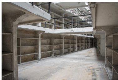
Bâtiment du dépôt, rez-de-chaussée : vue du vaisseau 4 vers le sud-ouest. Phot. Pierre Thibaut IVR31_20155901937NUCA
