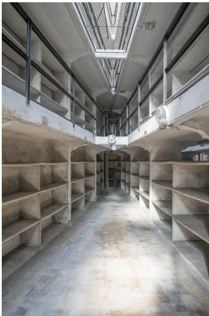
Bâtiment du dépôt, rez-de-chaussée : vue de l'extrémité ouest du vaisseau 4.
