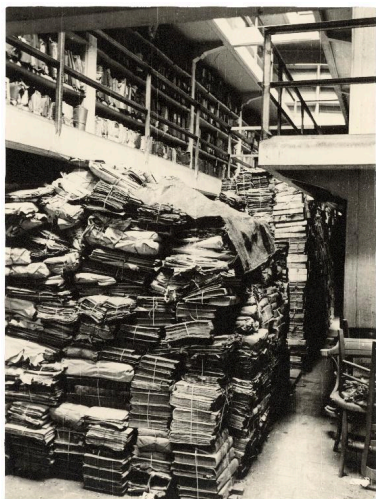
Vue de l'intérieur du dépôt en service, rez-de-chaussée, photographie (AD Nord ; 3 T 2027 / 74). Repro. Pierre Thibaut, Autr. Pierre Piétrésson de Saint-Aubin IVR32_20165901421NUCA
