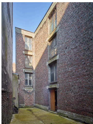
Vue de la cour sud est vers le bâtiment du dépôt. À noter : la présence de huit baies, qui sont d'origine.
