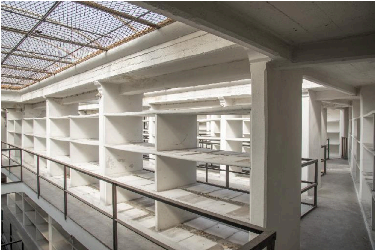
Bâtiment du dépôt, troisième étage : vue de l'extrémité est du dépôt depuis le vaisseau 4.
