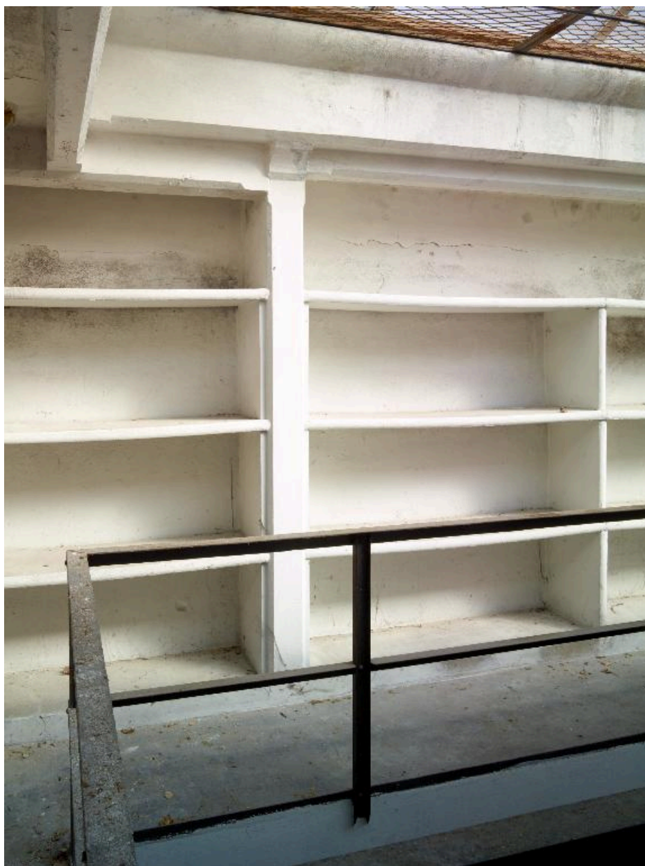
Bâtiment du dépôt, troisième étage : vue des rayonnages du vaisseau 4.
