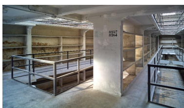
Bâtiment du dépôt, premier étage : vue des vaisseaux 3 et 4, vers l'ouest. Phot. Pierre Thibaut IVR31_20155902120NUCA
