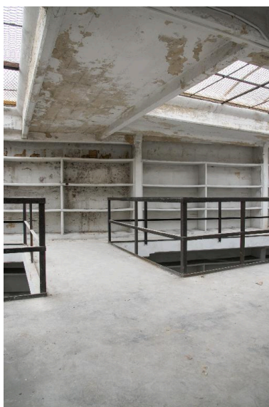
Bâtiment du dépôt, troisième étage : vue du palier transversal au vaisseau 4. Phot. Pierre Thibaut IVR31_20155901849NUCA
