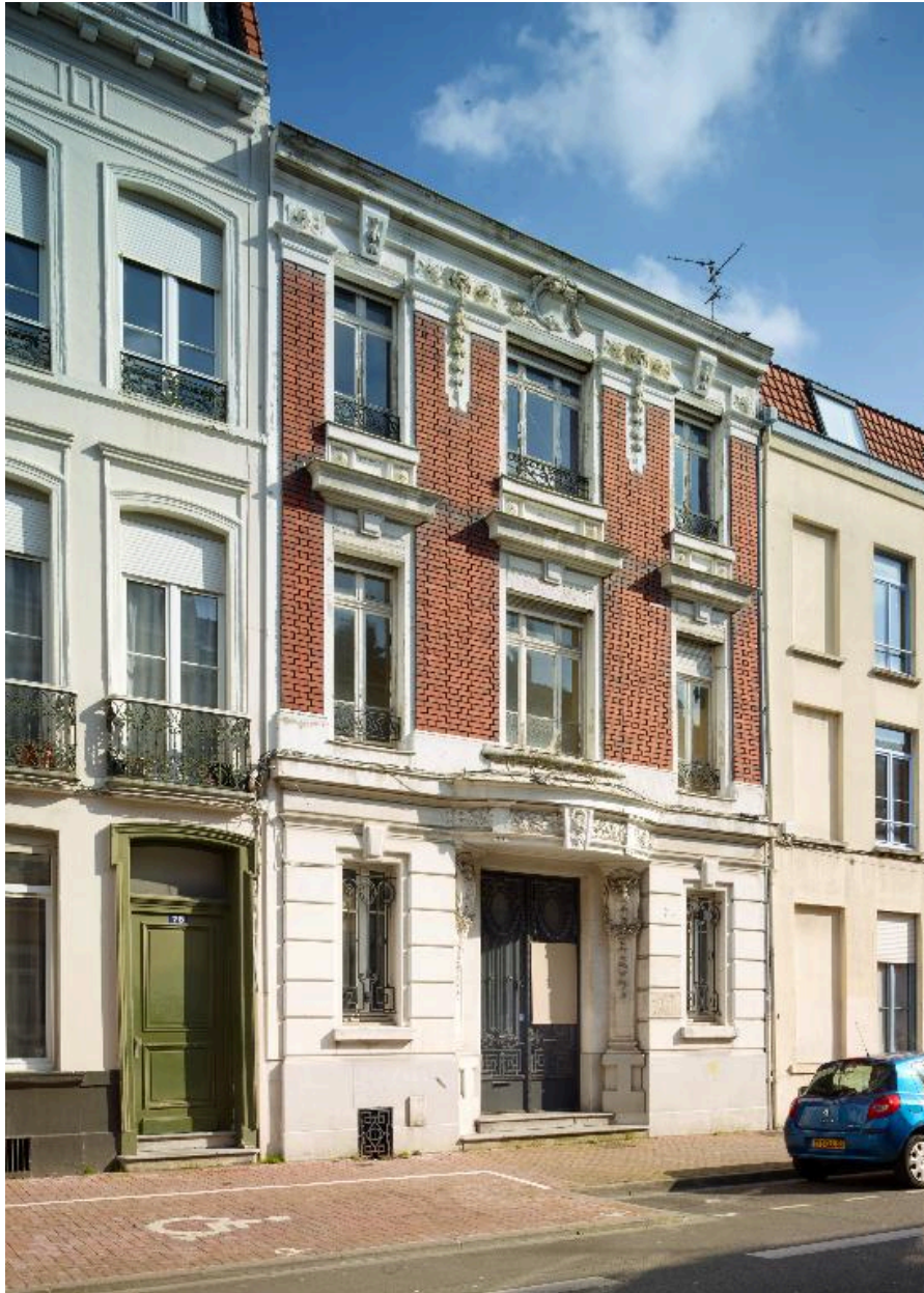
Vue générale de la façade du bâtiment administratif.
