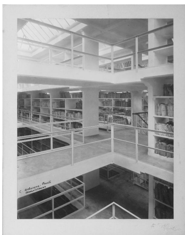
Intérieur du bâtiment du dépôt en service, vue prise depuis le vaisseau 4. À noter : on distingue un lanterneau. Photographie (IFA ; 076 Ifa 108/10 : 2-C-055). Repro. Pierre Thibaut, Phot. Cayez IVR32_20165901493NUCA
