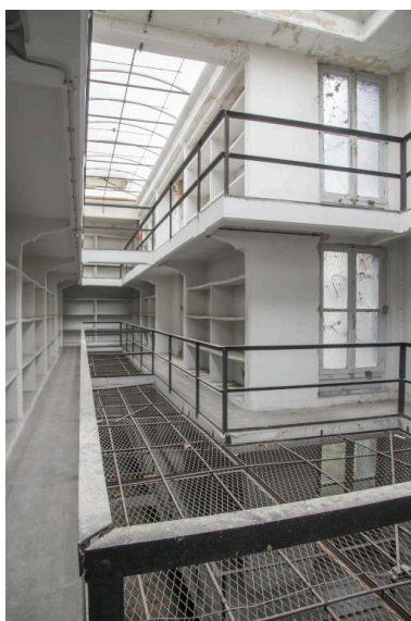
Bâtiment du dépôt, deuxième étage : vue du vaisseau 4 vers le sud-est. Phot. Pierre Thibaut IVR31_20155901830NUCA
