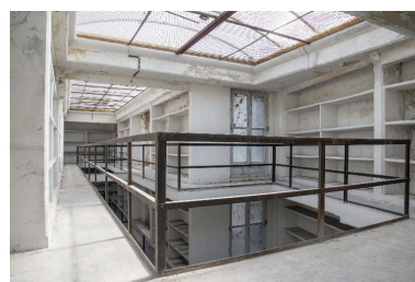
Bâtiment du dépôt, troisième étage : vue du vaisseau 4 vers l'est depuis le palier central. Phot. Pierre Thibaut IVR31_20155901905NUCA
