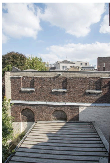
Vue du toit de la salle de triage et du bâtiment du dépôt depuis le premier étage du bâtiment administratif. On note le mur ouest en brique, réemployé et dont les baies ont été murées.
