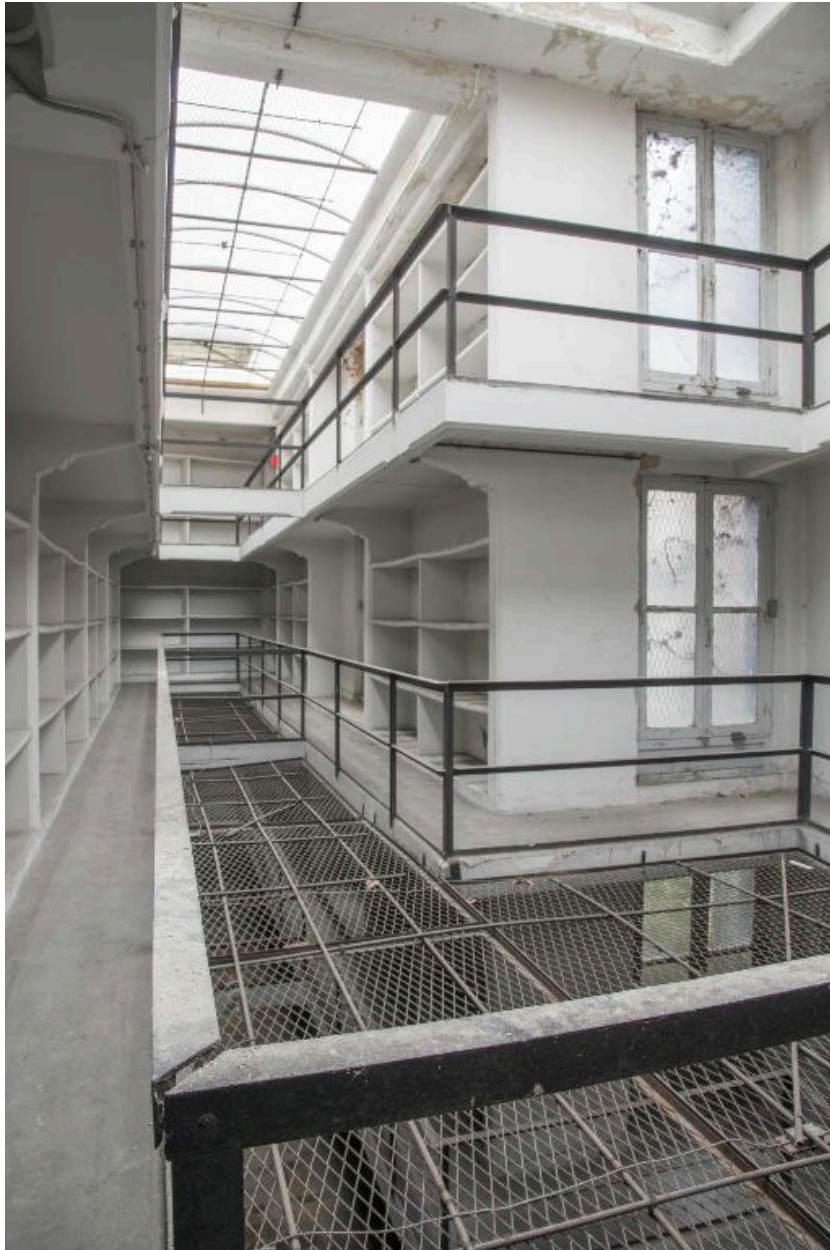
Bâtiment du dépôt, deuxième étage : vue du vaisseau 4 vers le sud-est.
