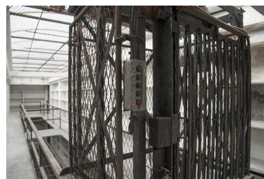
Bâtiment du dépôt, troisième étage : détail du monte-charge, vaisseau 1. Phot. Pierre Thibaut IVR31_20155901781NUCA
