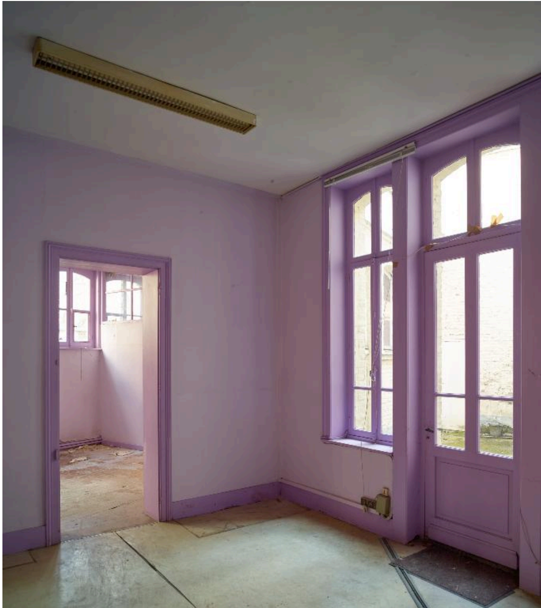
Bâtiment administratif, rez-de-chaussée : vue de la salle de consultation - bureau. Au fond, la salle de triage.
