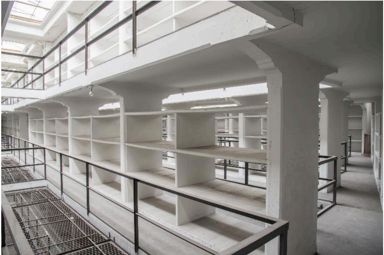
Bâtiment du dépôt, deuxième étage : vue depuis le vaisseau 4 des vaisseaux 3, 2 et 1 vers le nord.
