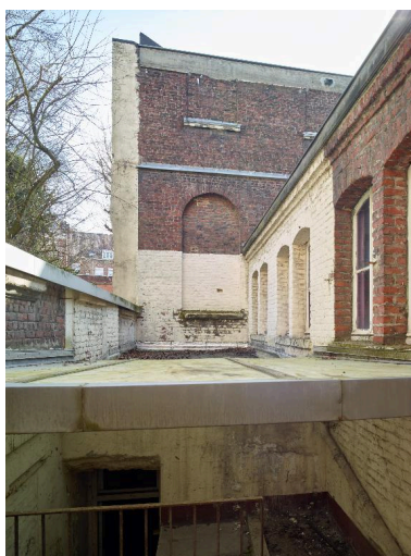
Vue depuis la cour nord vers le bâtiment du dépôt (au fond) et la salle de triage (à droite).
