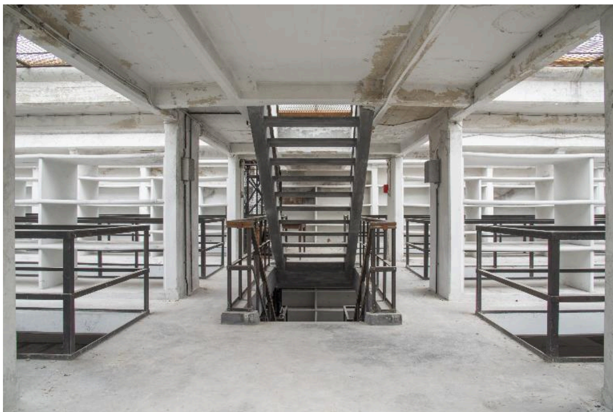
Bâtiment du dépôt, troisième étage : vue de l'escalier depuis le vaisseau 4, vers le nord.
