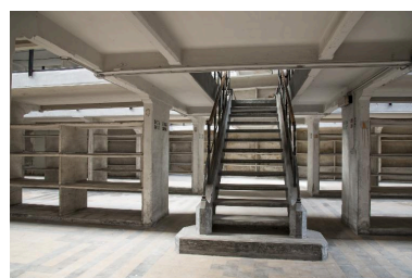
Bâtiment du dépôt, rez-de-chaussée : vue frontale de l'escalier depuis le vaisseau 1. Phot. Pierre Thibaut IVR31_20155901803NUCA
