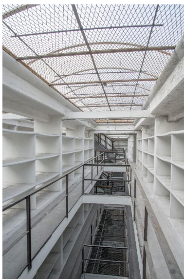
Bâtiment du dépôt, troisième étage : vue du vaisseau 2 depuis l'est. Phot. Pierre Thibaut IVR31_20155901874NUCA
