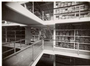
Vue transversale de l'intérieur du dépôt en service, photographie (AD Nord ; 3 T 2027 / 72).
