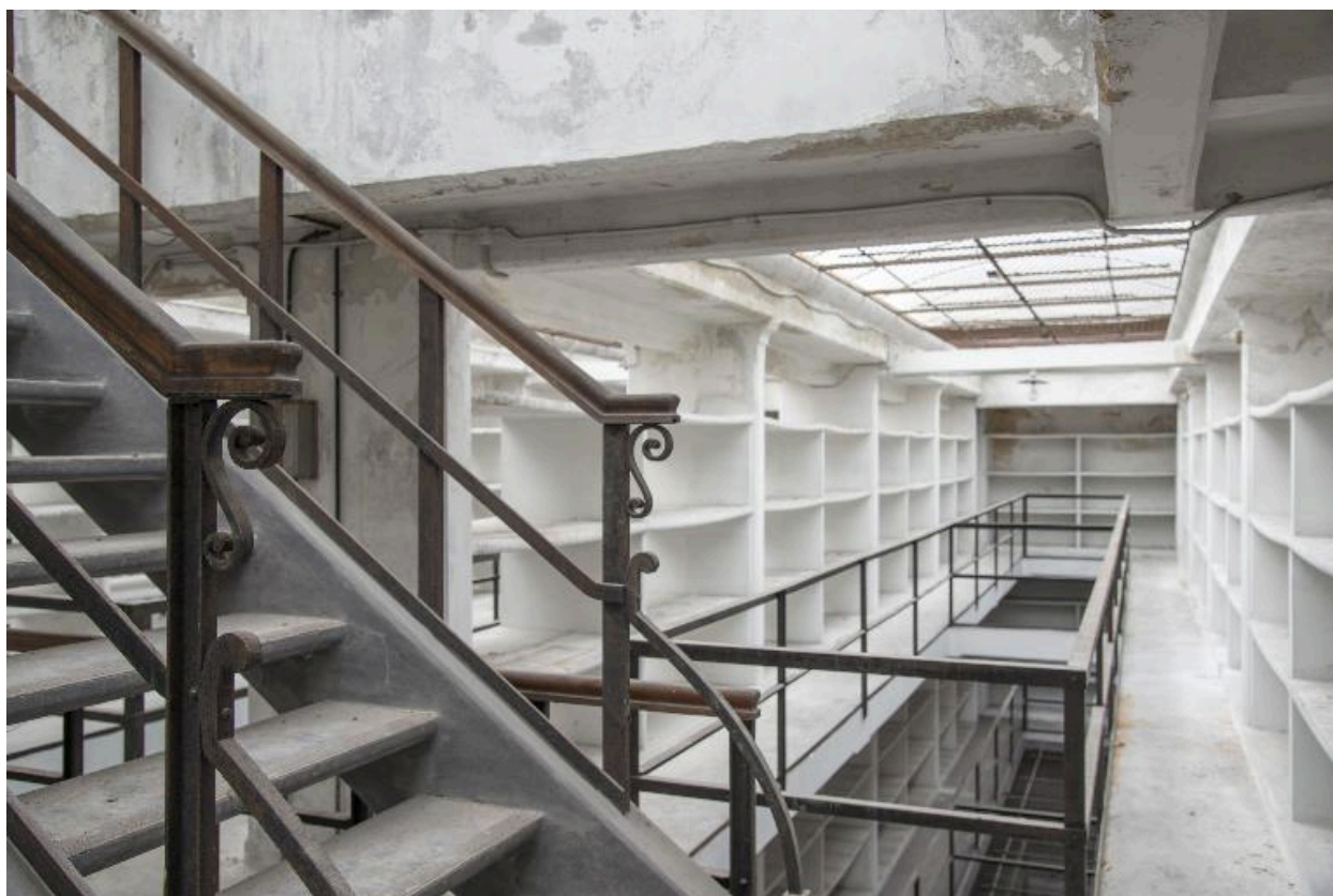
Bâtiment du dépôt, troisième étage : vue du vaisseau 2 vers l'ouest et détail de l'escalier.
