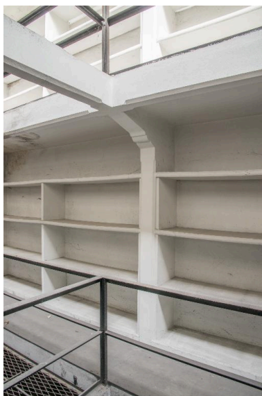
Bâtiment du dépôt, deuxième étage. Vue du système porteur en béton armé : pilier, console, entretoise. Phot. Pierre Thibaut IVR31_20155901837NUCA
