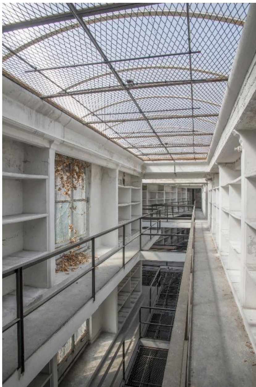
Bâtiment du dépôt, troisième étage : vue du vaisseau 4 vers l'ouest. A noter : la présence des baies donnant sur la cour sud-est.
