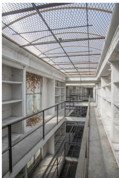
Bâtiment du dépôt, troisième étage : vue du vaisseau 4 vers l'ouest. A noter : la présence des baies donnant sur la cour sud-est. Phot. Pierre Thibaut IVR31_20155901765NUCA
