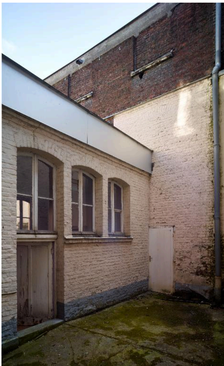
Vue de la cour sud ouest vers le bâtiment du dépôt (au fond) et la salle de triage (à gauche).
