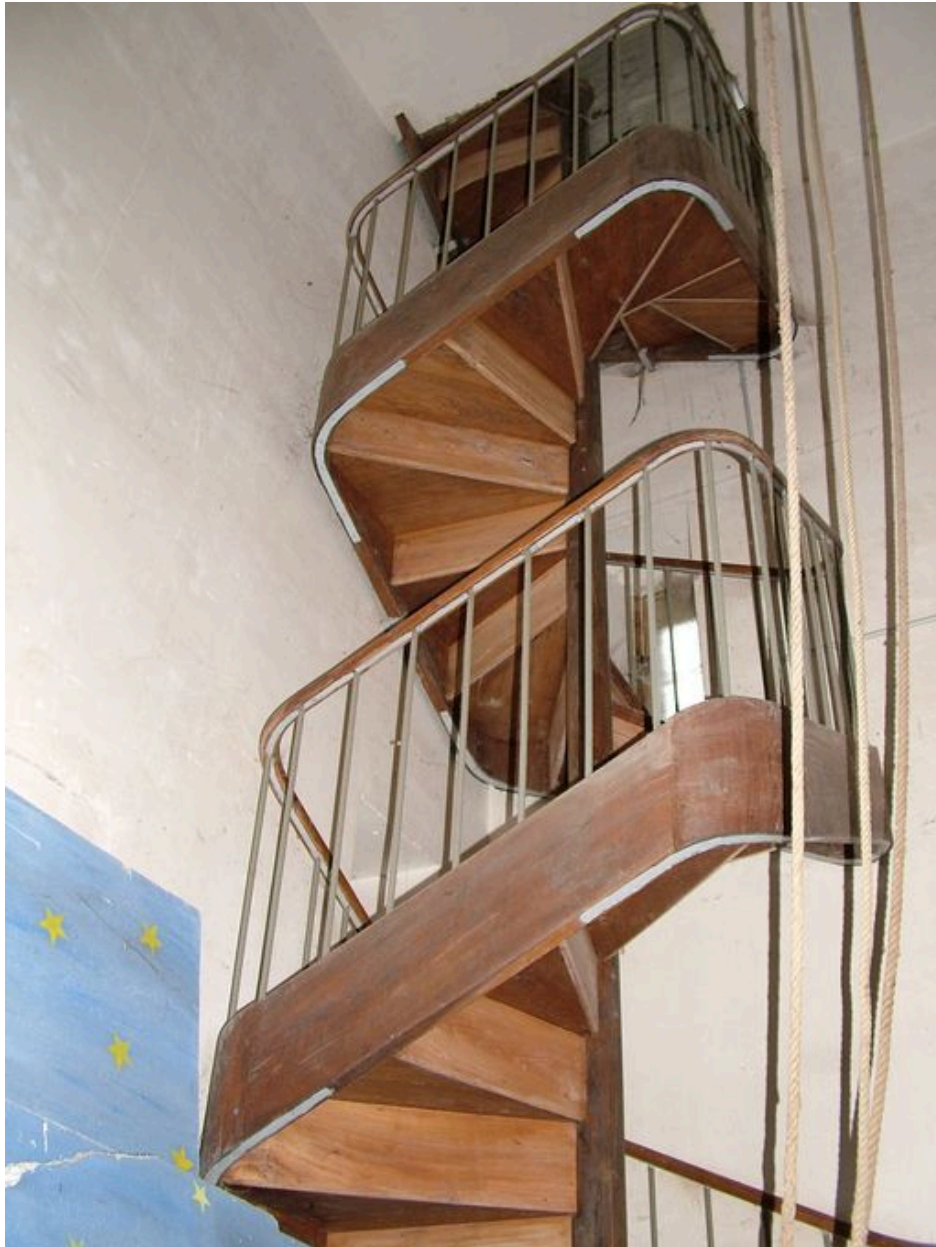
Vue de l'escalier du clocher.
