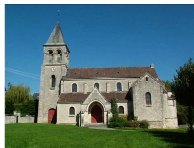
Vue générale. Phot. Inès Guérin IVR22_20030202453NUCA
