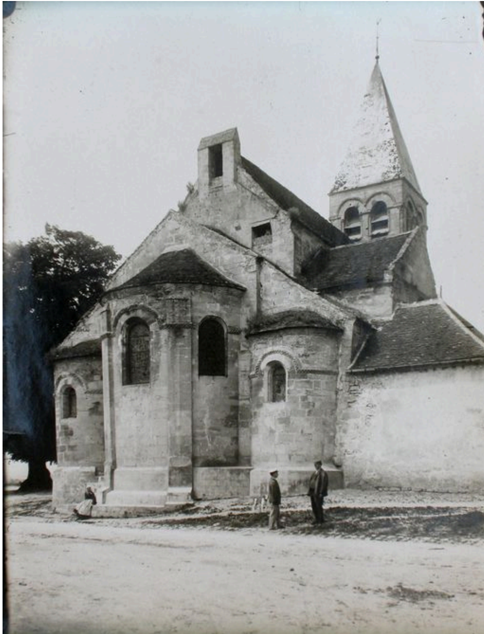
Vue ancienne du chevet (AD Aisne : 2 Fi Chevregny 1).
