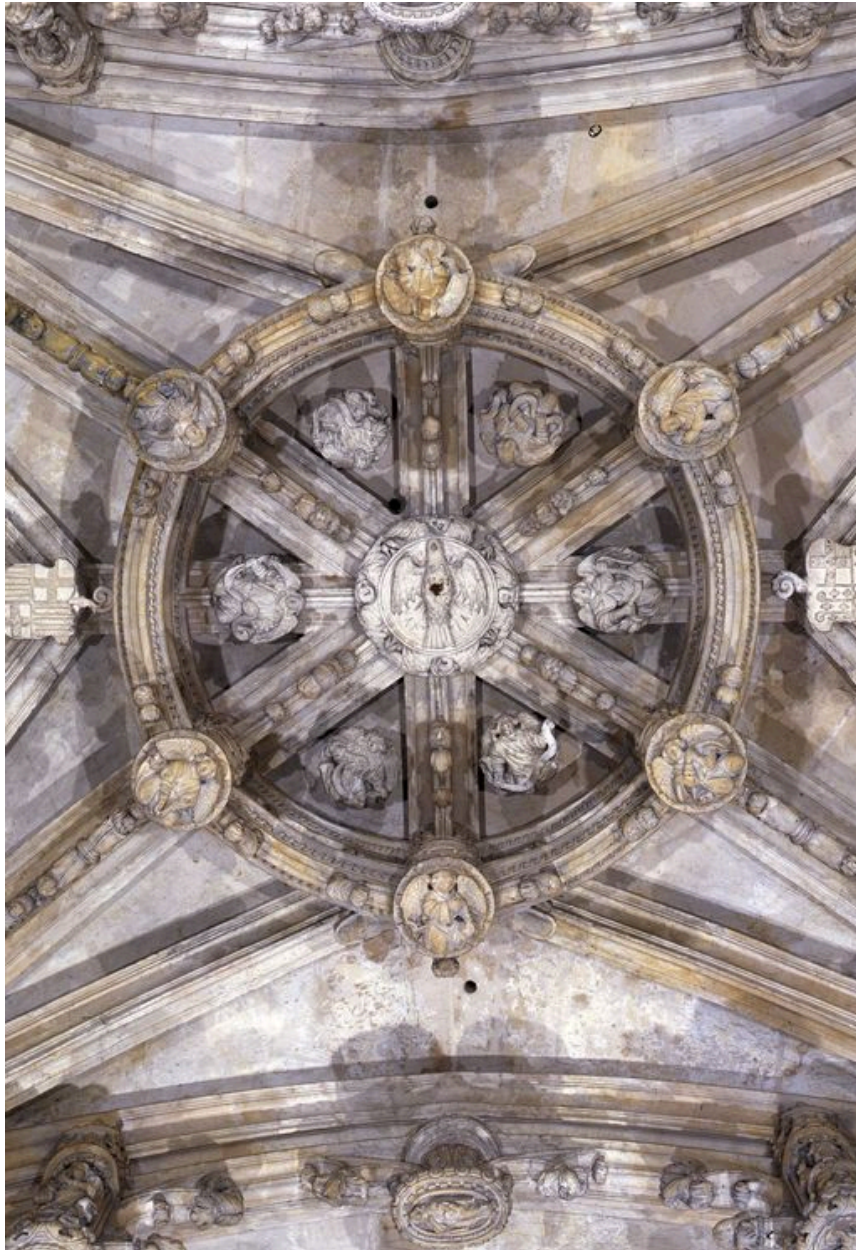
Vue intérieure : détail des voûtes de la chapelle Notre-Dame de Bon Secours.
