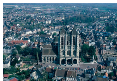
Vue aérienne depuis l'ouest. Phot. Jean-Claude Stamm IVR22_19876000135ZA
