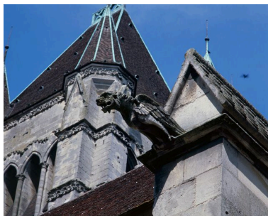
Tour sud-ouest. Phot. Thierry Lefébure IVR22_19976000227XA
