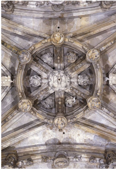
Vue intérieure : détail des voûtes de la chapelle Notre-Dame de Bon Secours.
