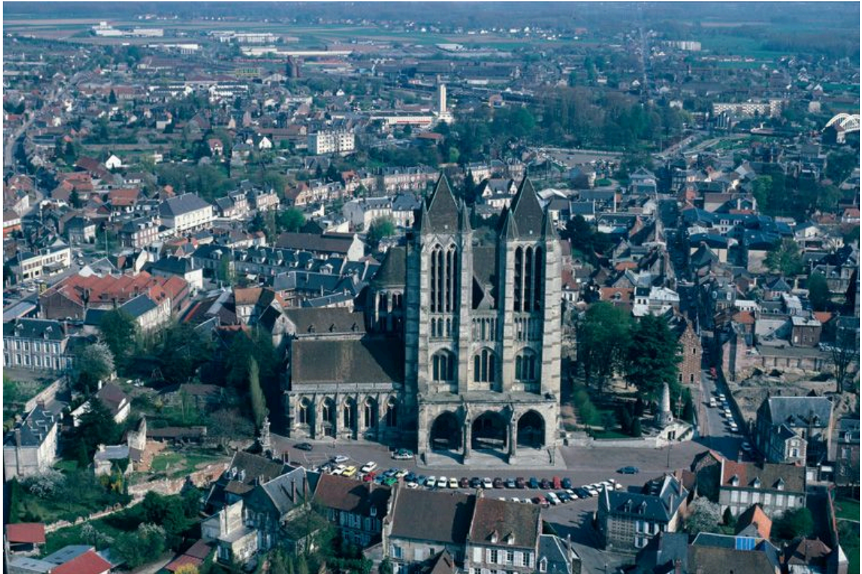
Vue aérienne depuis l'ouest.
