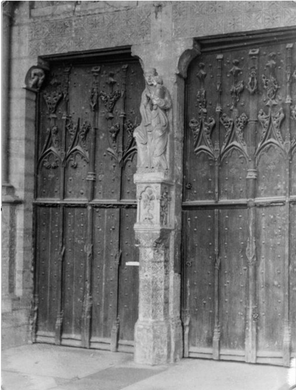
Portail central occidental.
