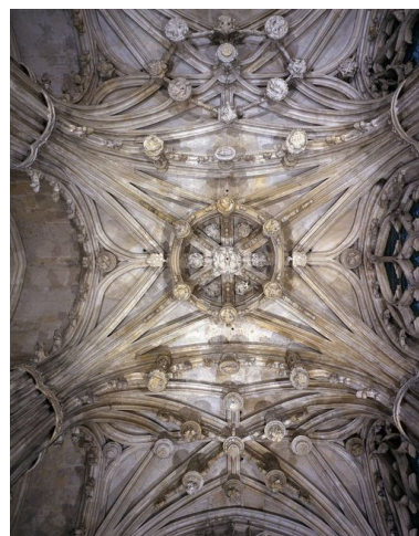
Vue intérieure : voûtes de la chapelle Notre-Dame de Bon Secours.
