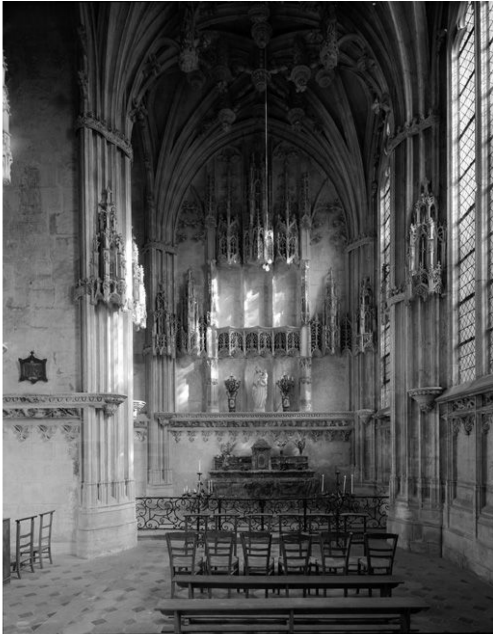
Vue intérieure de la 2e chapelle sud de la nef.
