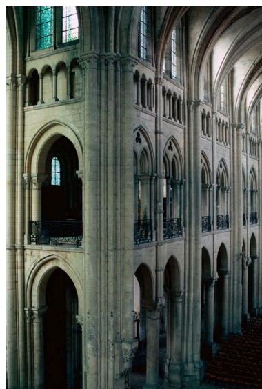
Vue intérieure de la nef et du bras sud du transept. Phot. Jean-Michel Perrin IVR22_19856000667ZA
