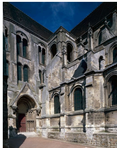
Tour sud-est et portail ouvrant sur le bras sud du transept. Phot. Thierry Lefébure IVR22_19976000234VA
