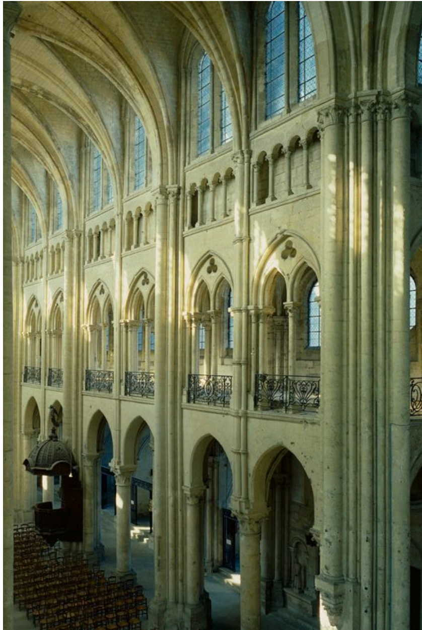
Vue intérieure de la nef, élévation nord.
