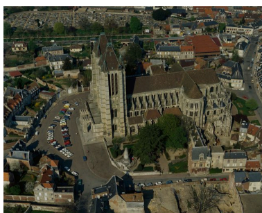
Vue aérienne depuis le sud. Phot. Jacques Philippot IVR22_19876000110XA
