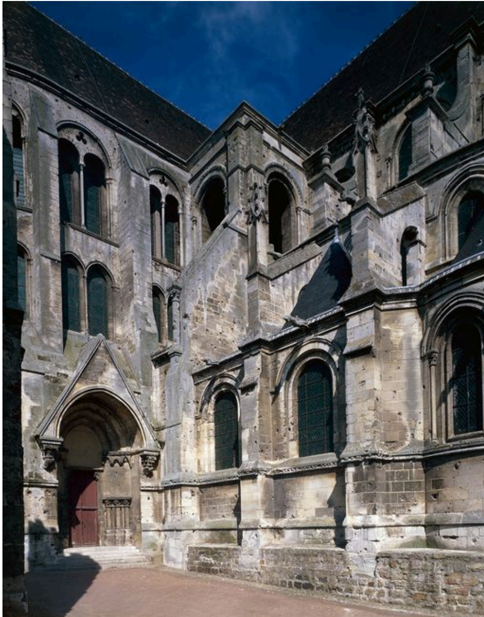
Tour sud-est et portail ouvrant sur le bras sud du transept.
