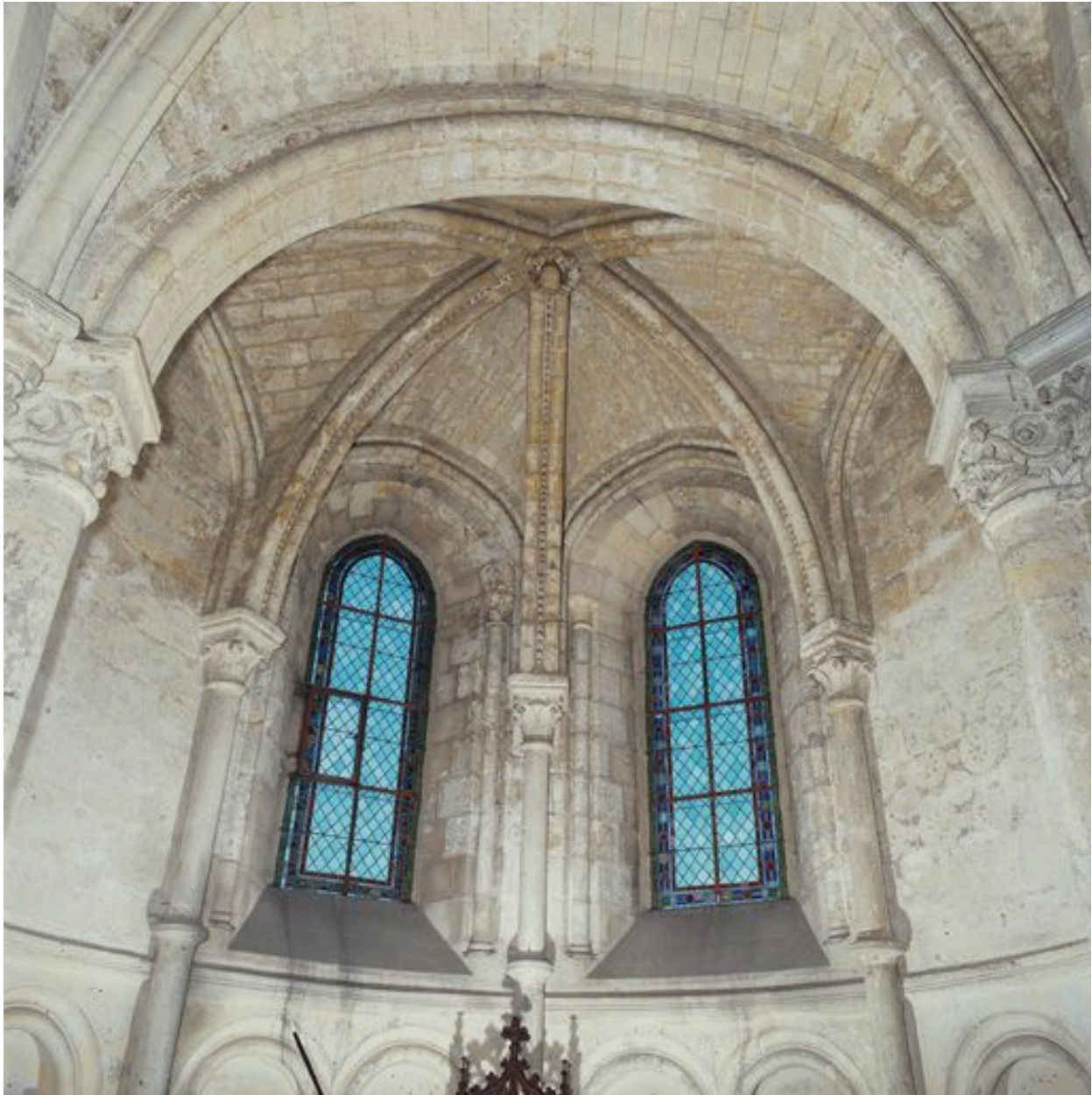
Vue intérieure du déambulatoire, chapelle rayonnante.
