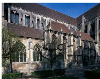
Façade sud. Phot. Thierry Lefébure IVR22_19976000235VA
