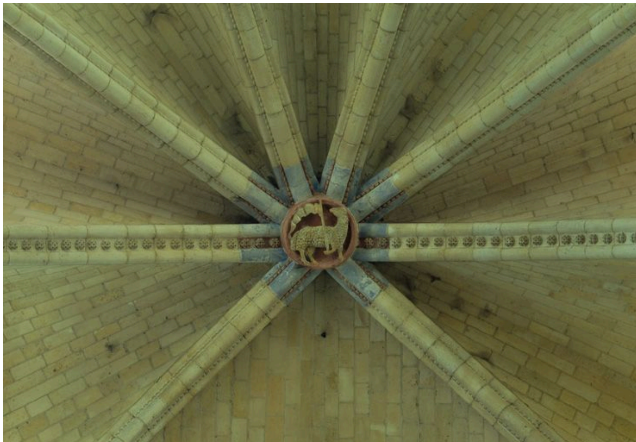
Vue intérieure des tribunes du chœur, clef de voûte avec l'Agnus Dei.
