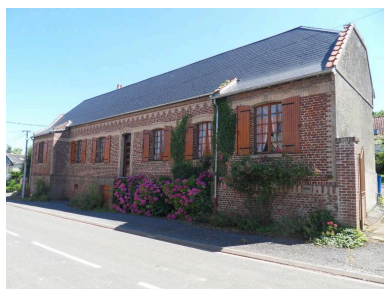
Maison, 27 rue d'Albert. Phot. Isabelle Barbedor IVR22_20128005136NUCA
