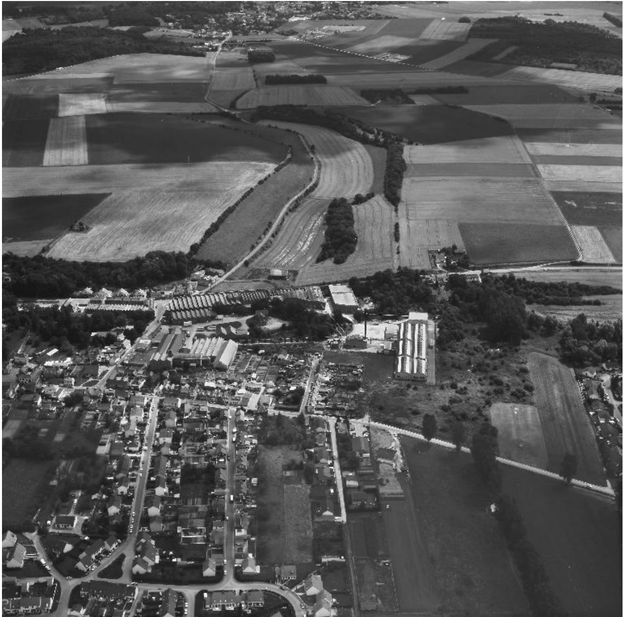
Vue aérienne, flanc ouest.
