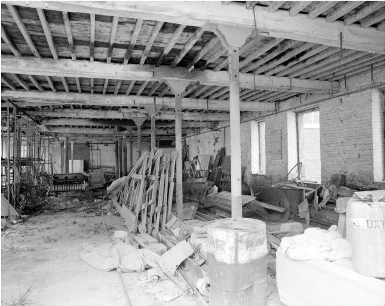
Ateliers de fabrication, rez-de-chaussée, vue intérieure.
