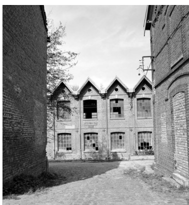
Ateliers de fabrication, flanc est détail. Phot. Thierry Lefébure IVR22_19898000034X
