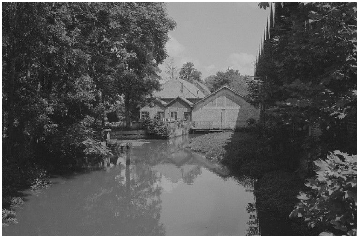
Bâtiment d'eau, flanc amont.
