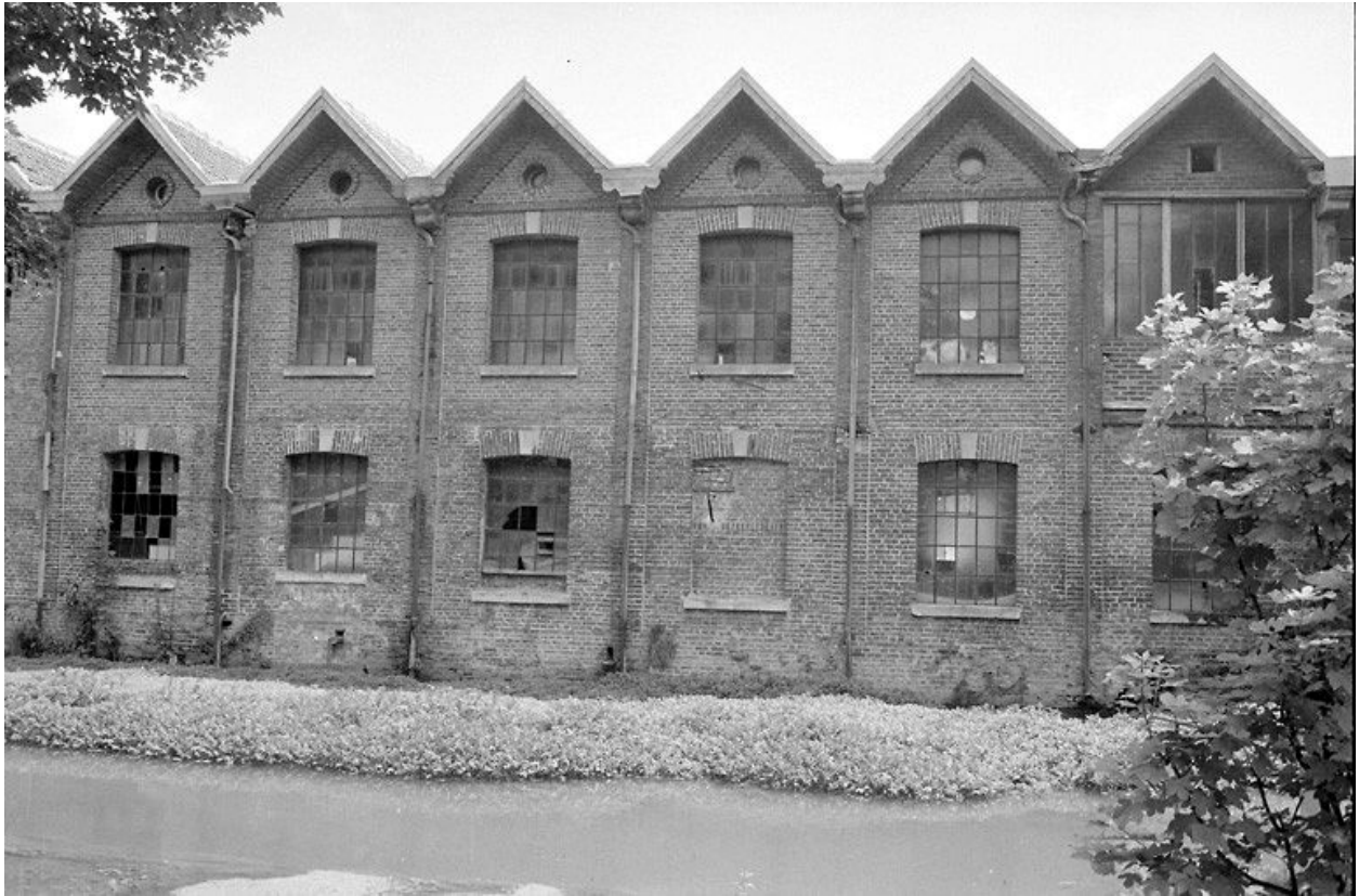
Ateliers de fabrication, flanc ouest, vue partielle.
