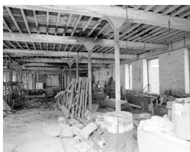
Ateliers de fabrication, rez- de-chaussée, vue intérieure. Phot. Thierry Lefébure
