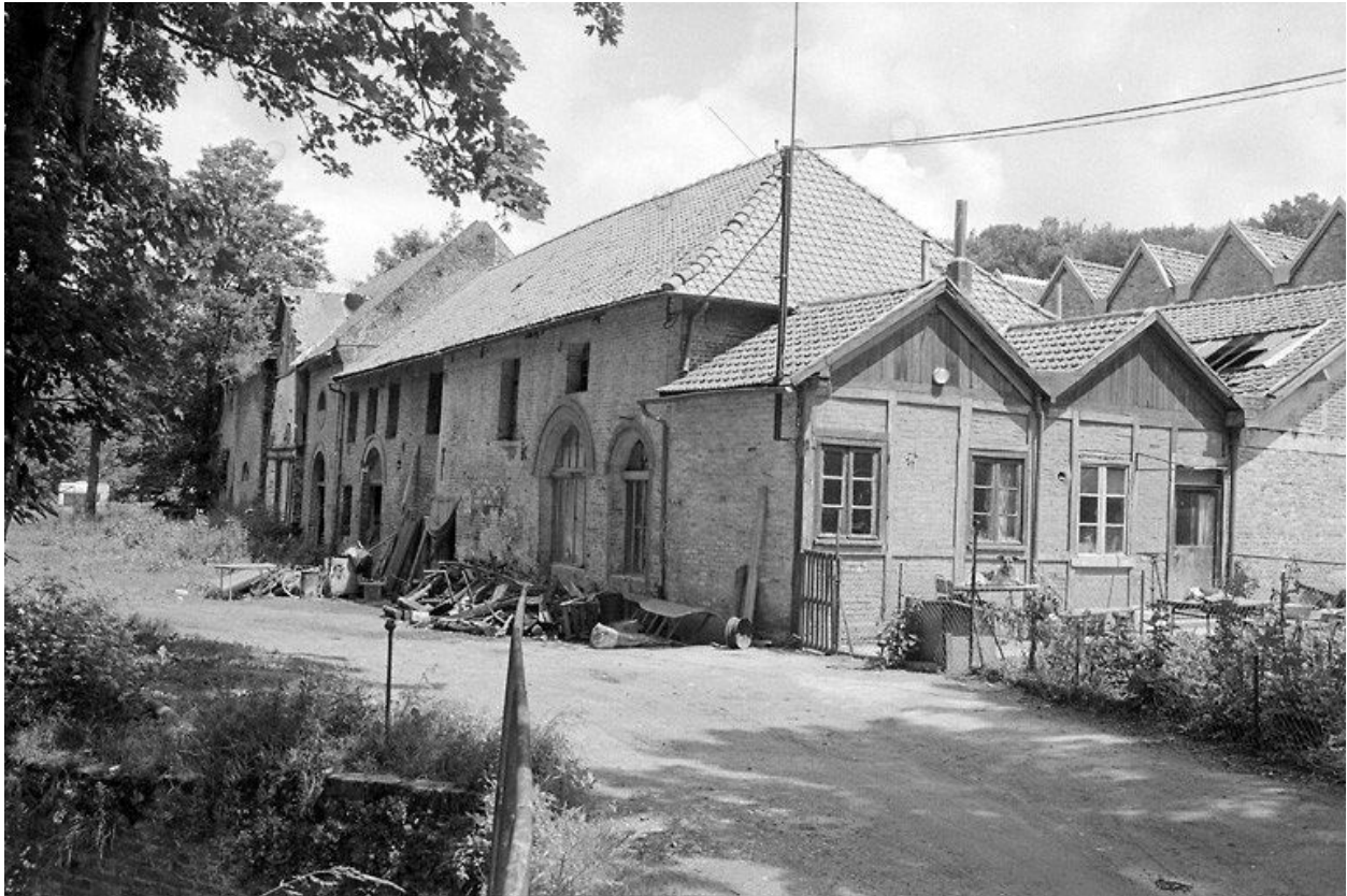
Atelier de fabrication, flanc ouest.
