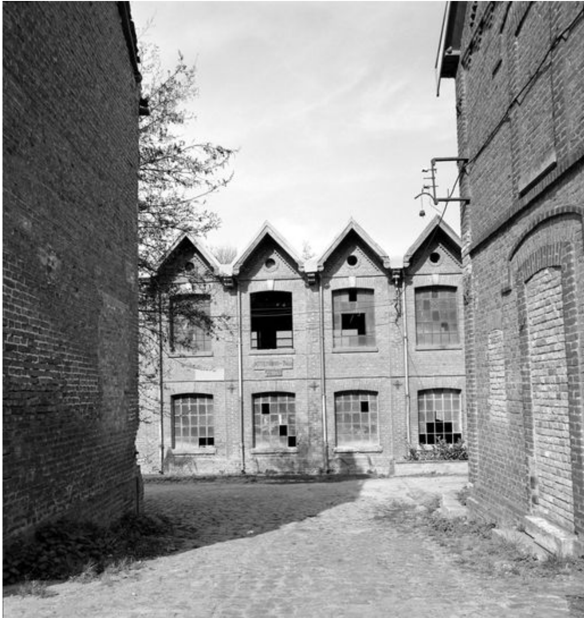
Ateliers de fabrication, flanc est détail.
