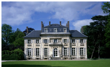
Elévation sud (façade sur cour) : vue de face. Phot. Irwin Leullier IVR22_19998000960VA
