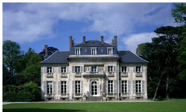
Elévation sud (façade sur cour) : vue de face. Phot. Irwin Leullier IVR22_19998000960VA
