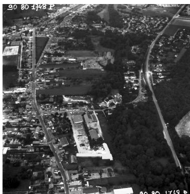
Vue aérienne, flanc sud. Phot. Phot'R IVR22_19908001748P
