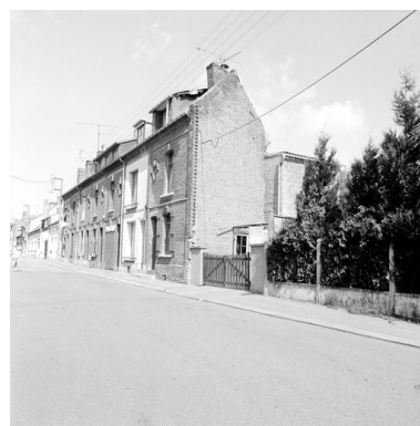
Logements d'ouvriers. Phot. Thierry Lefébure IVR22_19898000303X
