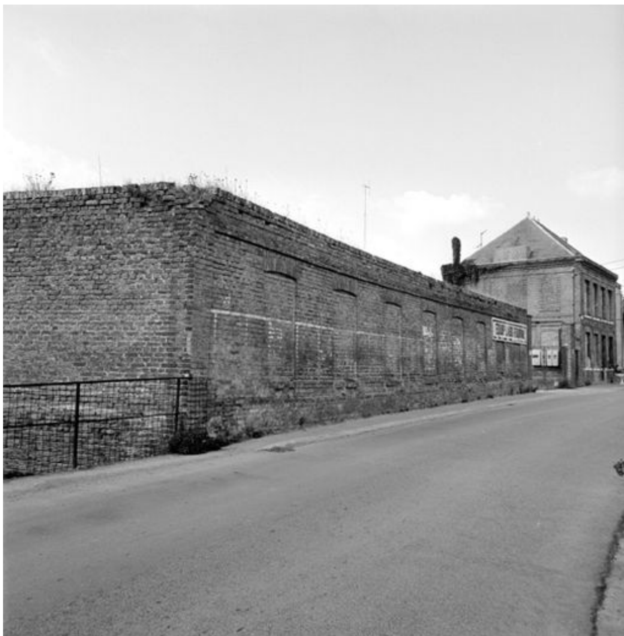
Atelier de fabrication, vestiges de l'élévation antérieure.
