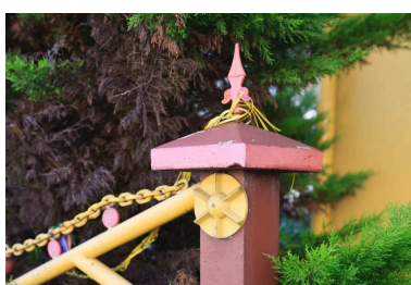
Façade sur rue, détail de la clôture. Phot. Hubert Bouvet IVR31_20126200315NUC4A
