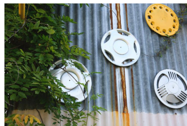
Détail d'enjoliveurs apposés sur le mur gouttereau d'un bâtiment voisin. Phot. Hubert Bouvet IVR31_20126200306NUC4
