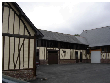
Vue des étables depuis la cour. Phot. Inès Guérin IVR22_20068005015NUCA
