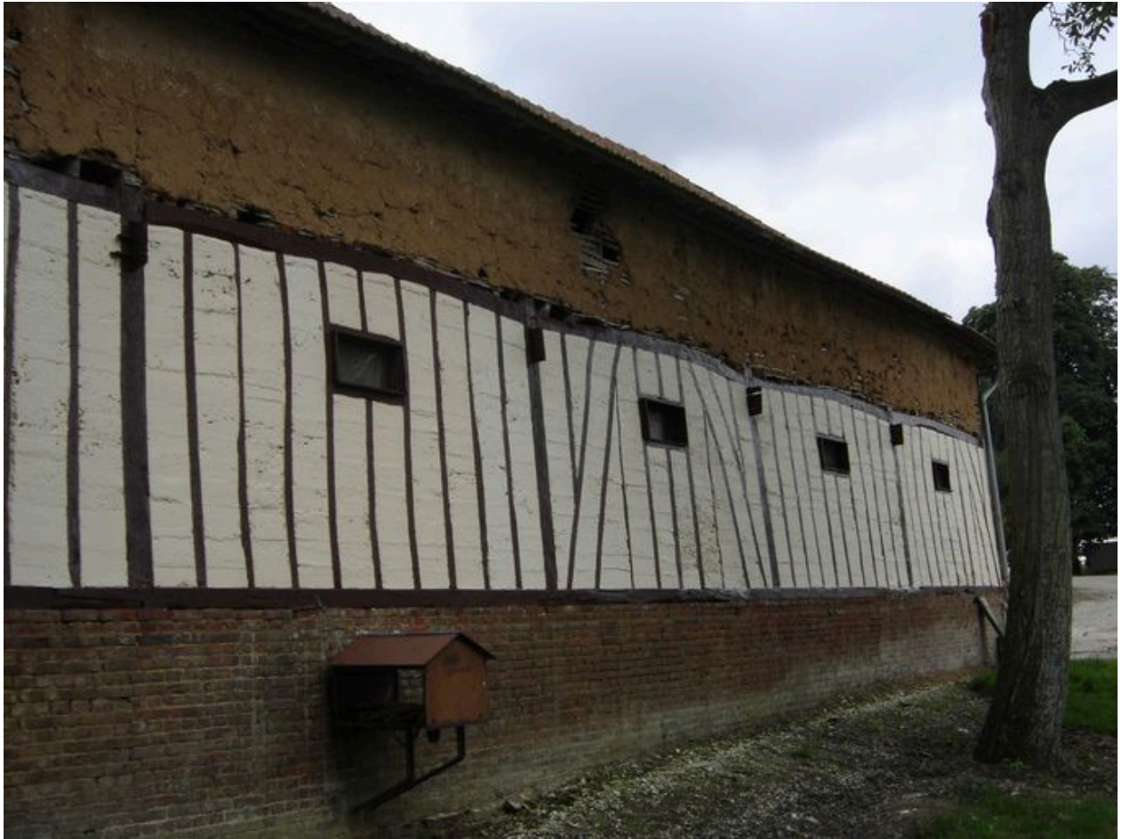
Vue postérieure de la grange.
