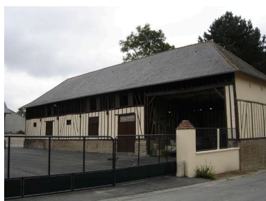
Vue de la grange depuis la cour. Phot. Inès Guérin IVR22_20068005017NUCA
