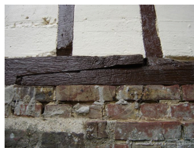
Détail de la sablière basse assemblée à trait de Jupiter. Phot. Inès Guérin IVR22_20068005019NUCA
