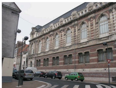
Façade de la bibliothèque sur la rue Gambetta Phot. Maya Bennani IVR31_20106204869NUCA
