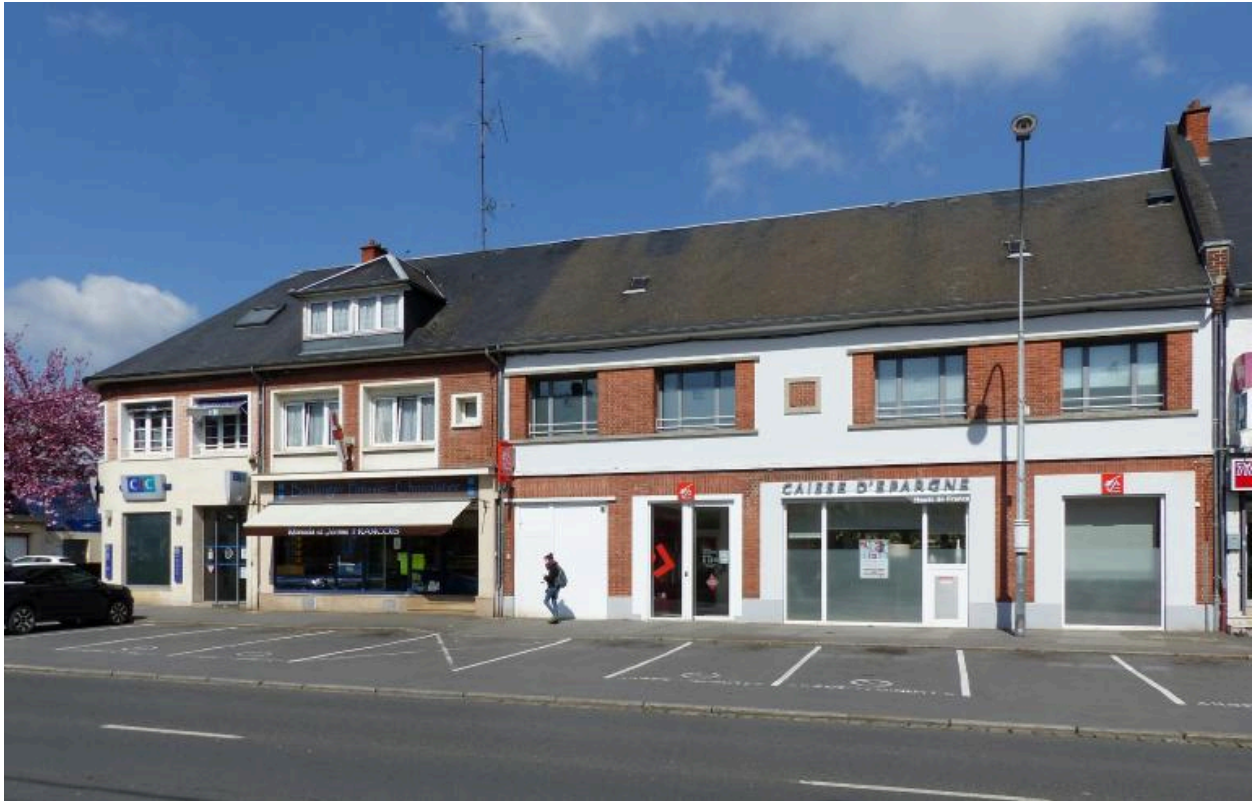
Boulevard Gambetta. Vue de détail du groupe est, 10 à 16 boulevard Gambetta.
