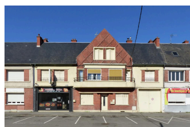
Partie centrale du groupe ouest, 20 à 32 boulevard Gambetta. Phot. Isabelle Barbedor IVR32_20220205077NUCA
