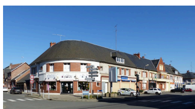
Vue du groupe ouest, boulevard Gambetta, depuis le carrefour de la rue Hoche. Phot. Isabelle Barbedor IVR32_20220205076NUCA
