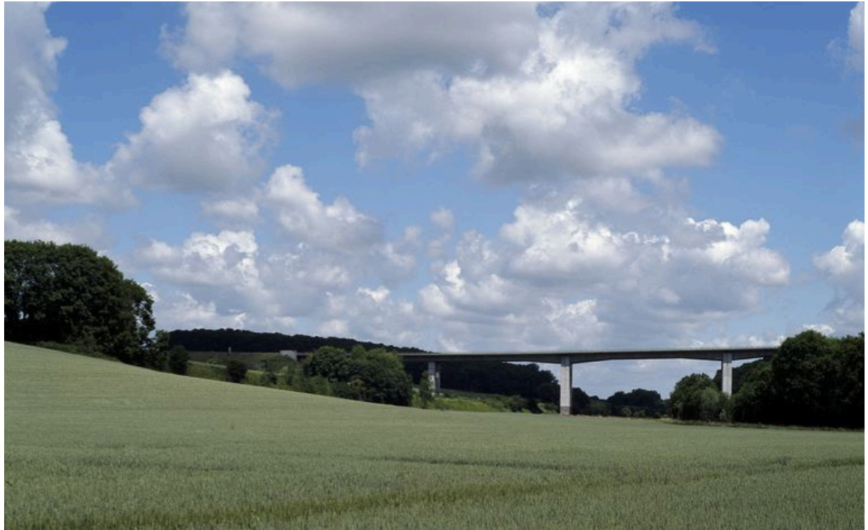
Viaduc de l'autoroute sur la vallée de Mouflers à Bouchon.
