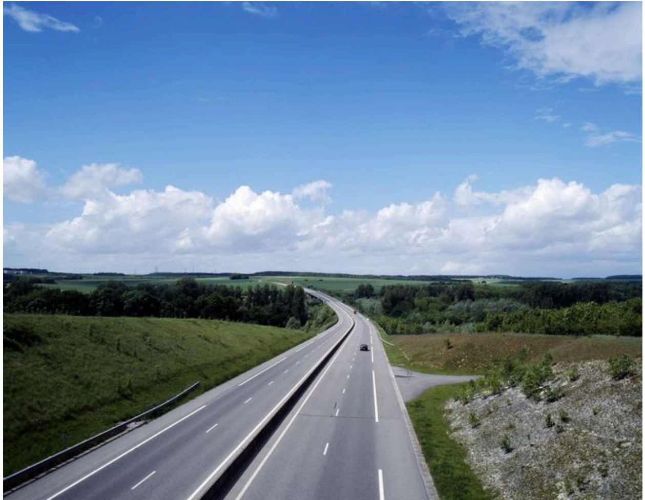
L'autoroute à Bettencourt-Saint-Ouen.
