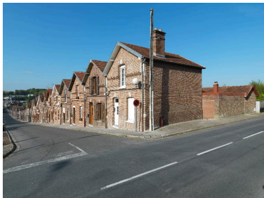
Cité ouvrière Saint Frères rue Yves Poiret à Flixecourt. Phot. Thierry Lefébure IVR22_20128000849NUC2A
