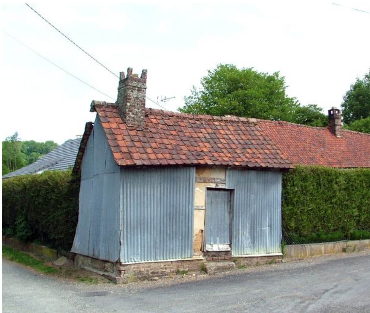
Ancien séchoir à chanvre domestique à Canaples.
