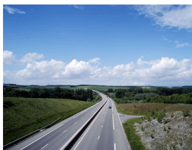
L'autoroute à Bettencourt-Saint-Ouen. Phot. Marie-Laure Monnehay-Vulliet IVR22_20098000175XA
