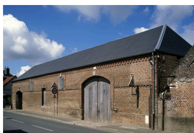
Ferme à Bettencourt- Saint-Ouen, 1897. Phot. Marie-Laure Monnehay-Vulliet IVR22_20098000191XA
