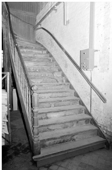
Vue intérieure : escalier. Phot. Benoît Dufournier IVR22_19878000461Z
