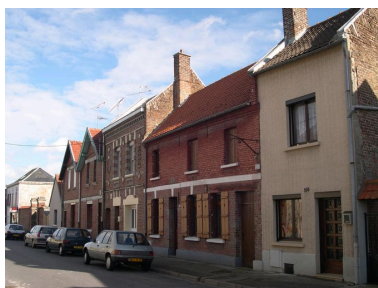
Maisons ouvrières, dites Cour Minard, 156 à 162 rue Jean-Catelas. Acquises par Cosserat en 1929. Phot. Isabelle Barbedor IVR22_20048010471NUCA
