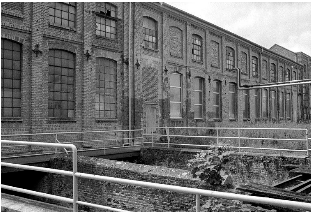
Bâtiment d'eau et atelier de fabrication.
