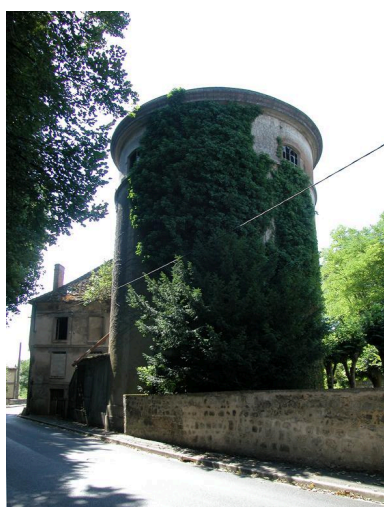
Vue du silo.
