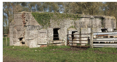
Vue de trois-quarts vers le nord-est Phot. Jean-Marc Ramette IVR31_20145904874NUCA
