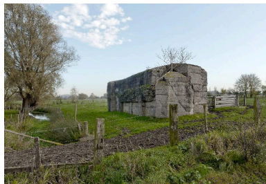
Vue latérale, vers le sud-est Phot. Jean-Marc Ramette IVR31_20145904877NUCA
