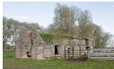
Vue de trois-quarts vers le nord-est Phot. Jean-Marc Ramette IVR31_20145904878NUCA
