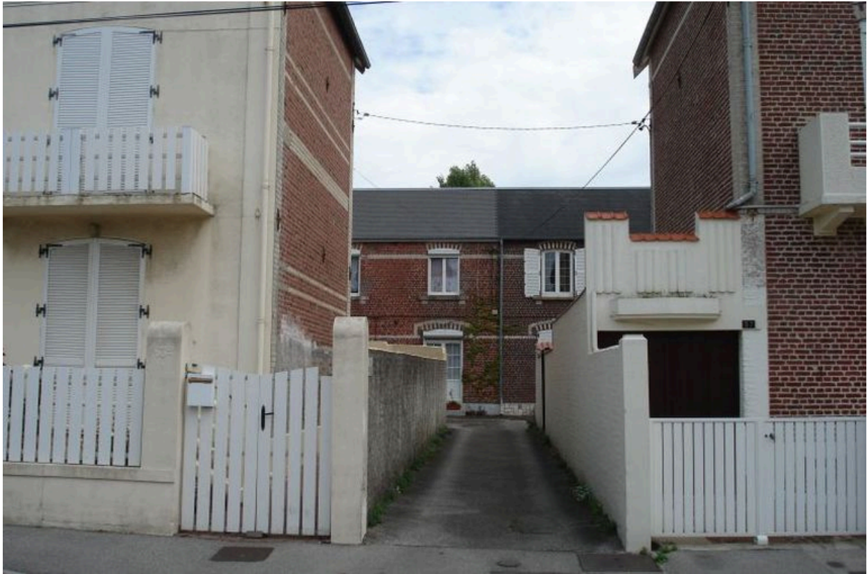
Vue du passage donnant accès à la cour.
