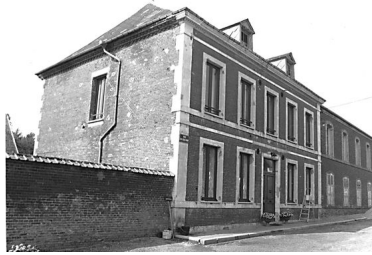
Vue depuis le nord-est. Phot. Xavier-Philippe Guiochon IVR22_19980203176Z
