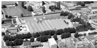
Vue aérienne, flanc est. Phot. Phot'R IVR22_19888001251P
