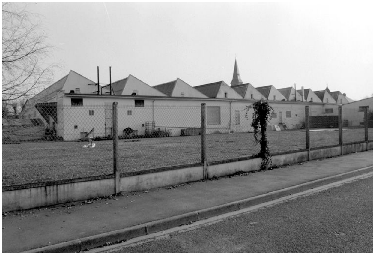
Ateliers de fabrication, flanc ouest.
