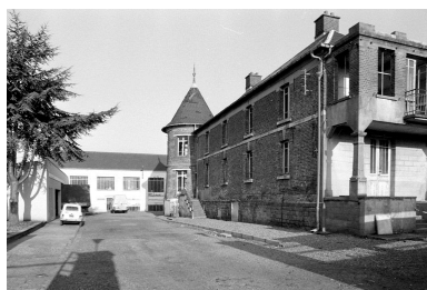
Bureau et logement patronal. Phot. Benoît Dufournier IVR22_19918000359Z
