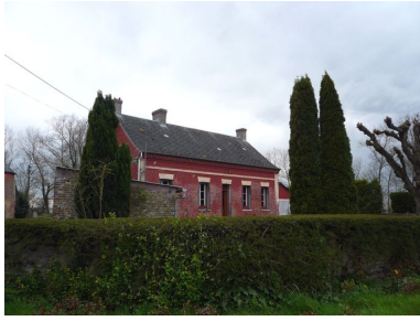
Vue du logis depuis la cour. Phot. Inès Guérin IVR22_20078005725NUCA
