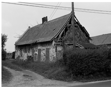
Logis de ferme, rue Morimetz, vue générale. Phot. Philippe Dapvril IVR31_20055900973X
