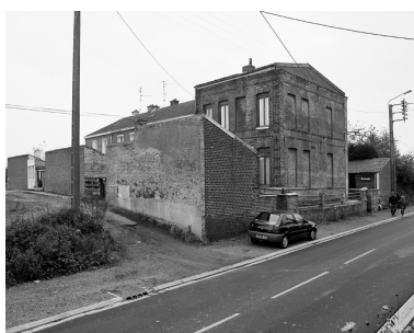
Vue générale de l'ancienne caserne de douanes, rue Molière. Phot. Philippe Dapvril IVR31_20045900699X
