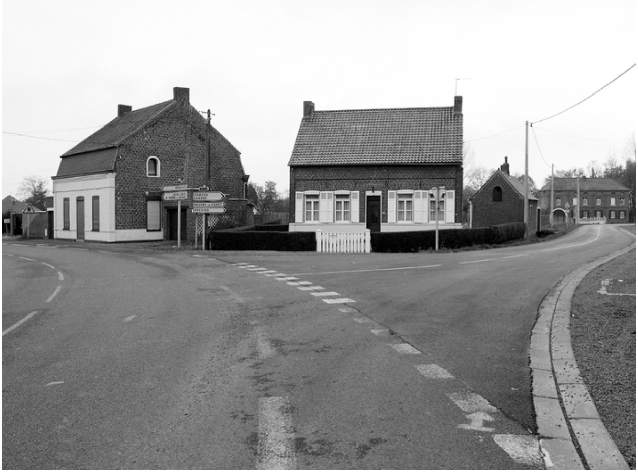
Maison élémentaires à l'entrée de Rumegies, à l'angle de la rue du grand Chemin et rue de Morimetz.
