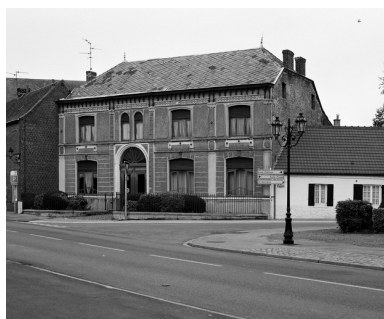
Maison de maître, 204, rue de l'Eglise, vue générale. Phot. Philippe Dapvril IVR31_20045900683X
