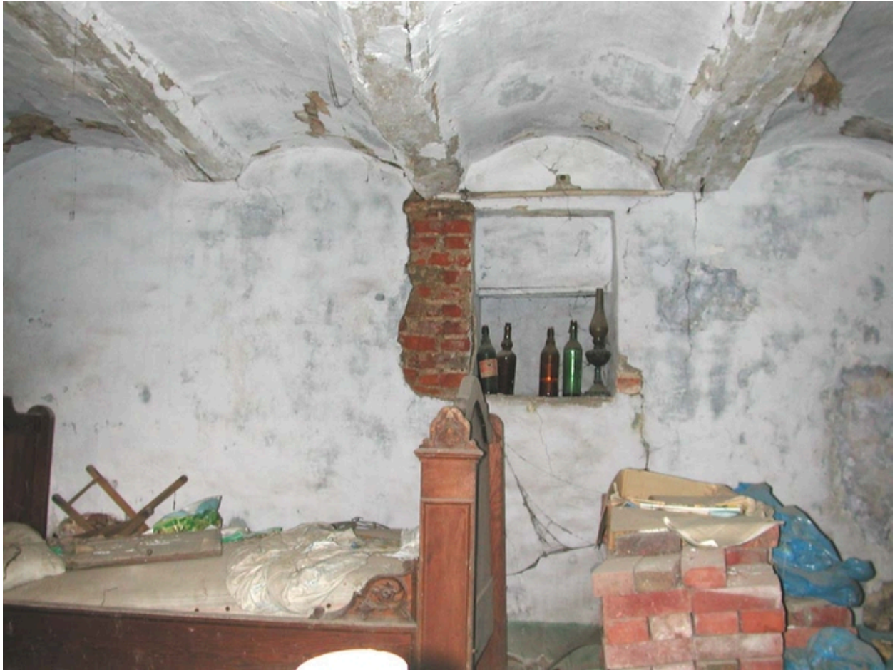
Logis de ferme, rue Morimetz, vue générale intérieure.
