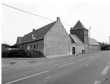
Ferme, 443, rue du Grand Chemin, vue générale. Phot. Philippe Dapvril IVR31_20045900662X
