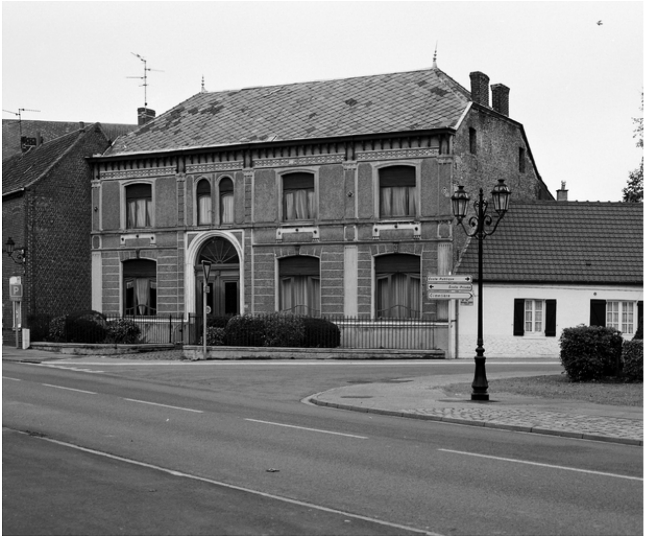
Maison de maître, 204, rue de l'Eglise, vue générale.
