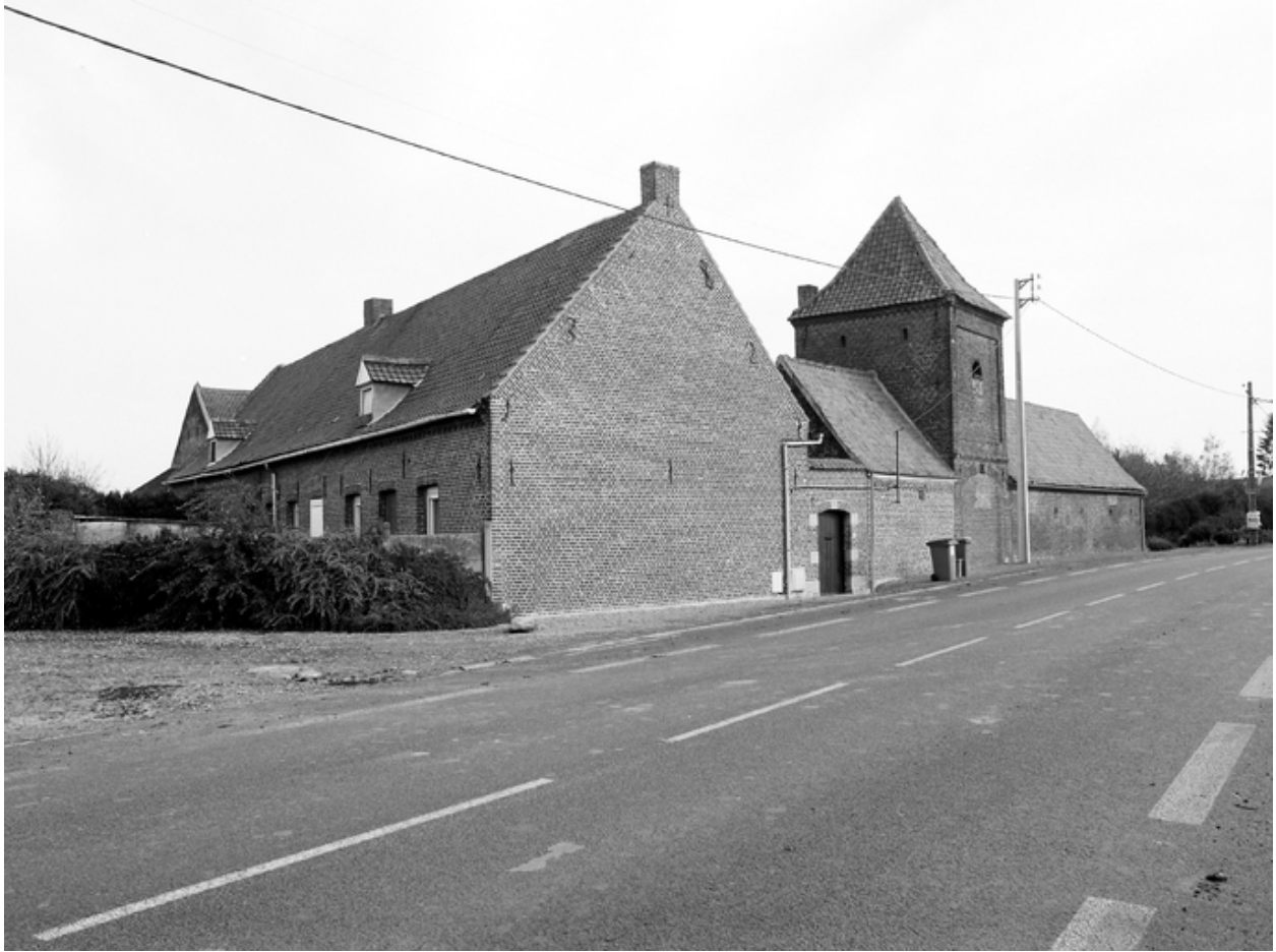
Ferme, 443, rue du Grand Chemin, vue générale.
