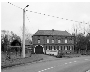
Ferme, 115, rue Morimetz, vue générale du logis. Phot. Philippe Dapvril
