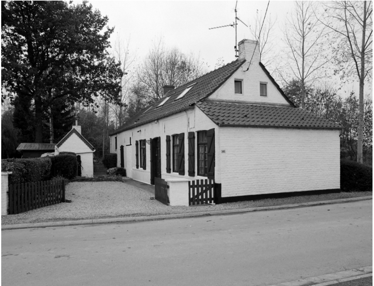
Ferme élémentaire, 583, rue Prière, logis et fournil.
