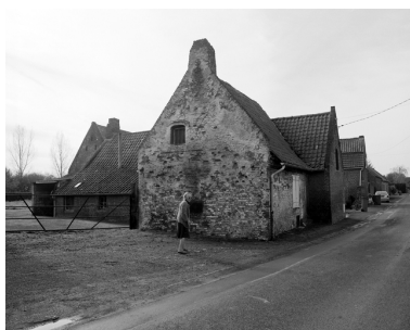
137, rue de la Caisse, pignon. Phot. Philippe Dapvril IVR31_20045900668X
