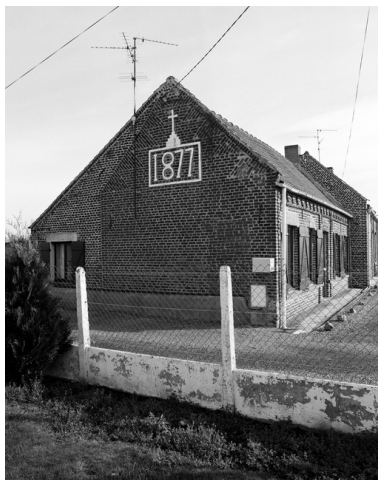
Ferme élémentaire, 340, rue des Haies. Phot. Philippe Dapvril IVR31_20045900670X
