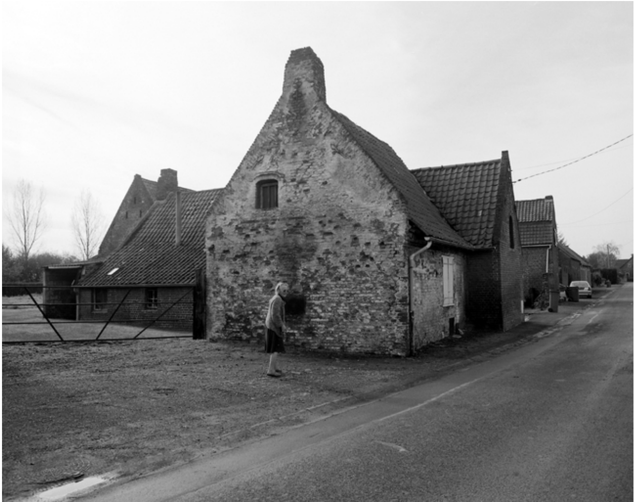
137, rue de la Caisse, pignon.
