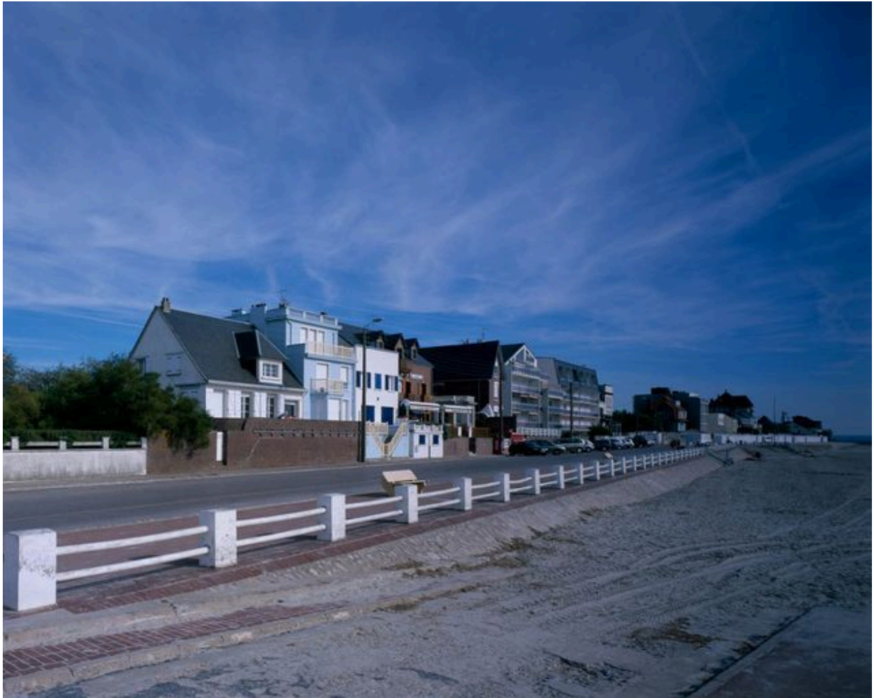
La digue Jules-Noiret, vers le sud-est.
