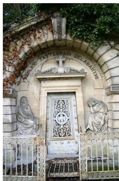
Vue rapprochée de la façade sculptée du tombeau-chapelle. Phot. Caroline Vincent IVR22_20098000776NUCA
