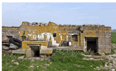
Elévation sud. De gauche à droite : Resserre à mitrailleuse sous la banquette de tir, niches à munitions, aération et entrée est Phot. Jean-Marc Ramette IVR31_20145904765NUCA
