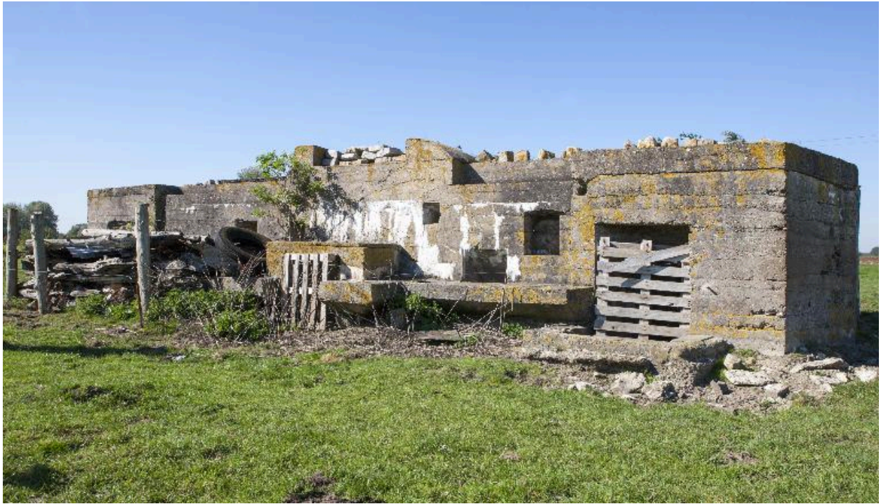
Elévation sud, vers le nord-ouest
