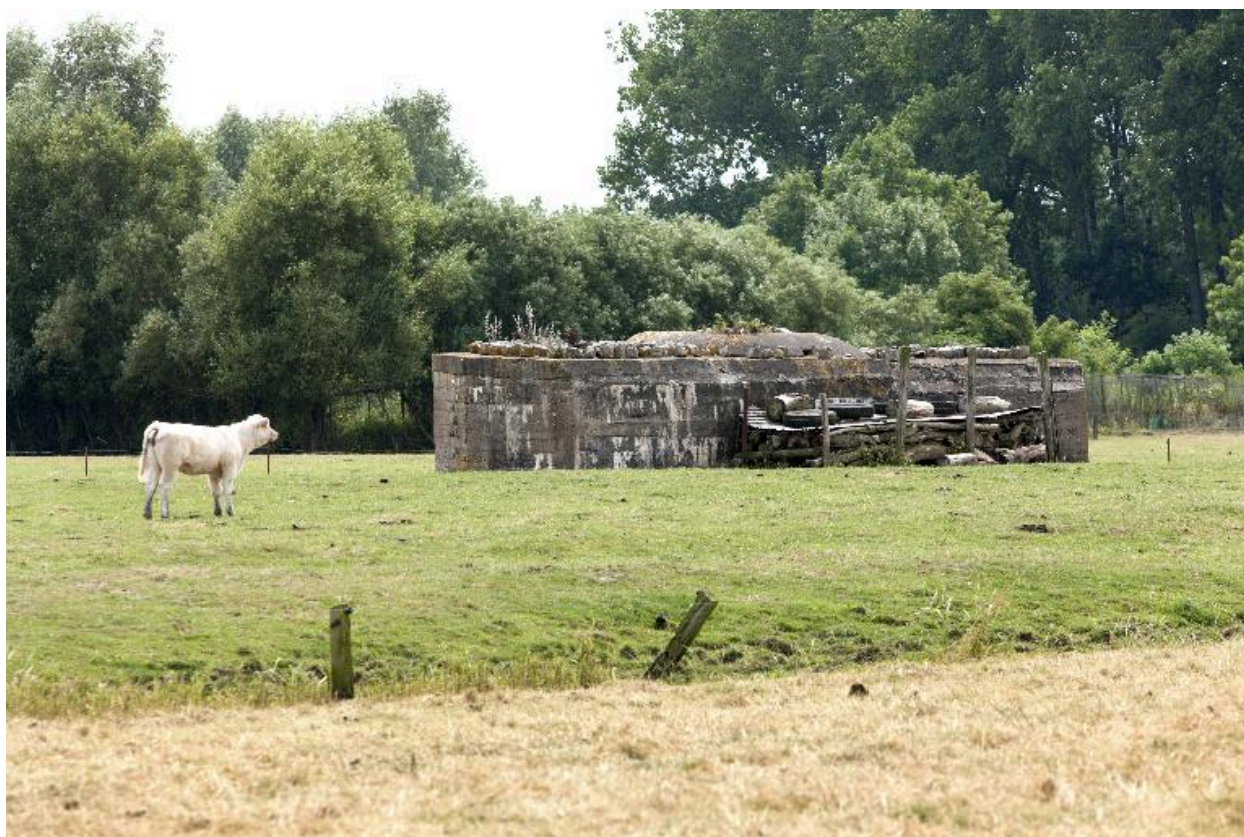
Vue générale vers le sud-ouest
