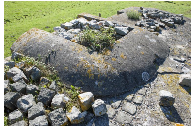
Depuis le couvrent, détail du poste de tir Phot. Pierre Thibaut IVR31_20155901669NUCA
