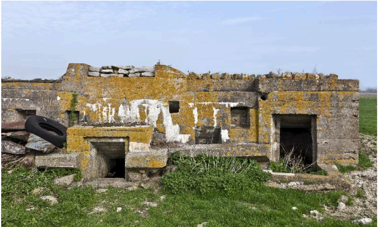
Elévation sud. De gauche à droite : Resserre à mitrailleuse sous la banquette de tir, niches à munitions, aération et entrée est
