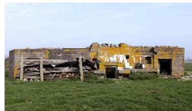
Elévation sud, vers le nord Phot. Jean-Marc Ramette IVR31_20145904764NUCA
