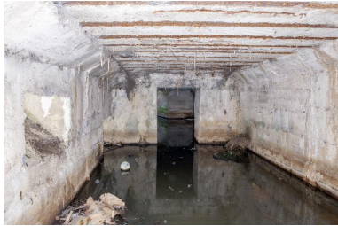
Vue intérieure en enfilade Phot. Pierre Thibaut IVR31_20155901670NUCA
