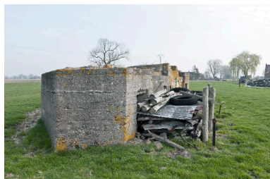
Vue de trois-quarts, vers le nord-est Phot. Jean-Marc Ramette IVR31_20145904761NUCA
