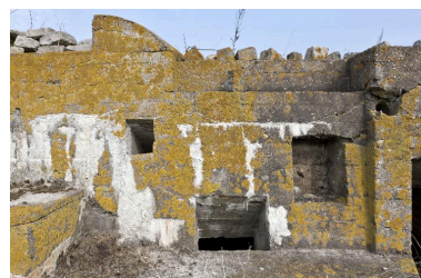
Elévation sud. Niches à munitions et aération est Phot. Jean-Marc Ramette IVR31_20145904763NUCA
