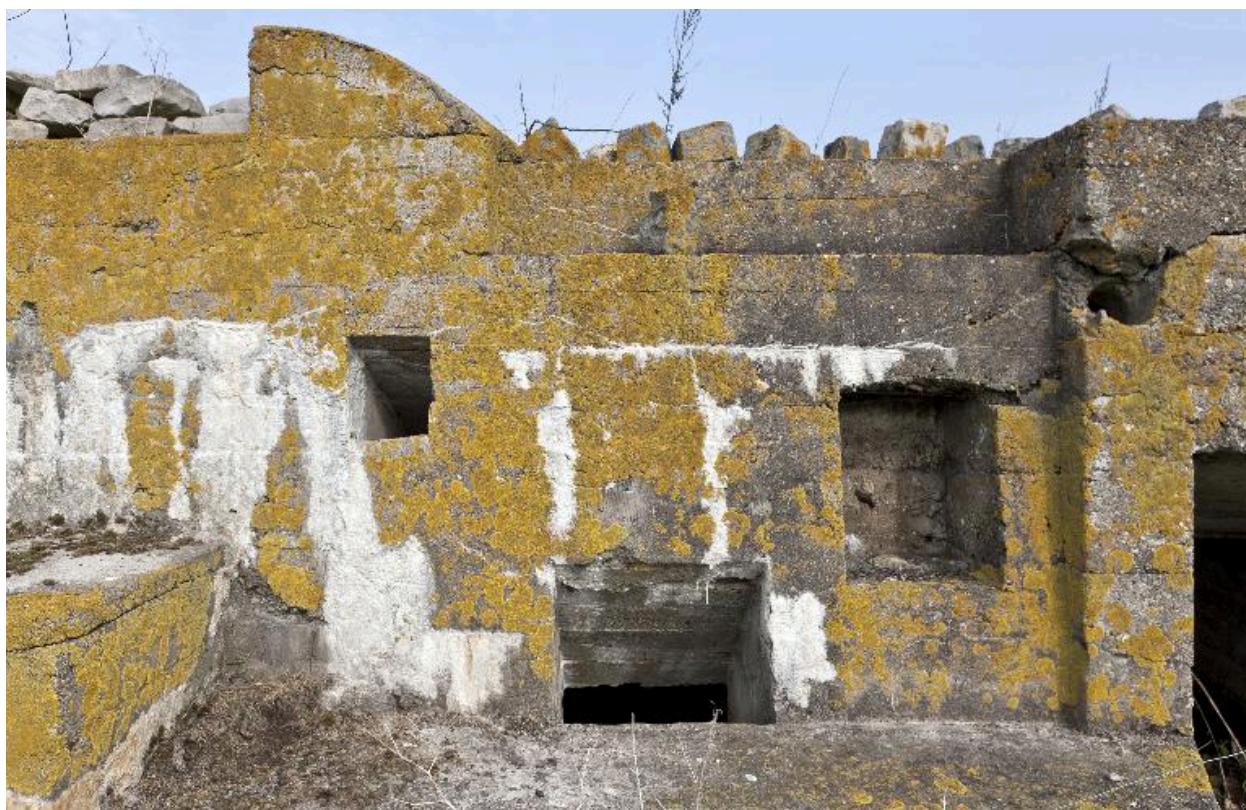
Elévation sud. Niches à munitions et aération est
