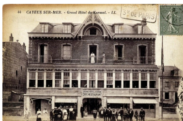
L'ancien Kursaal avec sa terrasse couverte, carte postale, 1er quart 20e siècle (coll. part.). Phot. Monnehay-Vulliet Marie-Laure IVR22_20058000460XAB
