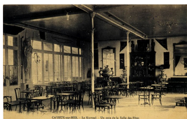
Intérieur du Kursaal, carte postale, 1er quart 20e siècle (coll. part.). Phot. Monnehay-Vulliet Marie-Laure IVR22_20058000456XAB
