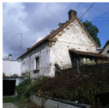
Vue du pignon extérieur du logis. Phot. Marie-Laure Monnehay-Vulliet IVR22_20098000265XA
