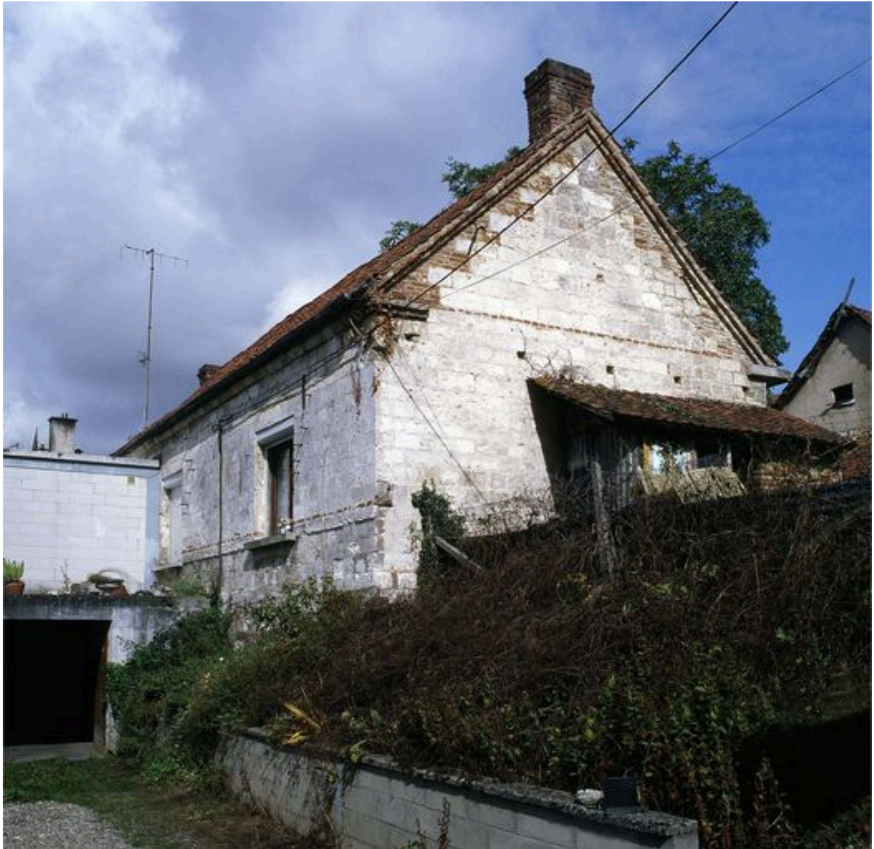
Vue du pignon extérieur du logis.
