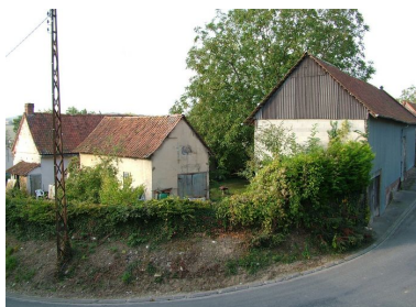
Vue générale depuis la rue d'En-Haut. Phot. Frédéric Fournis IVR22_20098005507NUCA
