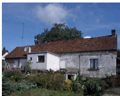
Vue postérieure du logis. Phot. Marie-Laure Monnehay-Vulliet IVR22_20098000264XA
