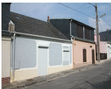
Maison, 13 et 15 rue de la Corderie. Phot. Elisabeth Justome IVR22_20048001670NUCA
