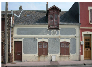
Maison de serrurier, 52 rue de Saint-Valery, daté de 1905 (date portée), portant les initiales 'HD', Haudiqet-Darty. Phot. Elisabeth Justome IVR22_20048001669NUCA
