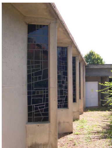
Vue des fenêtres de la façade ouest, depuis le nord. Phot. Isabelle Barbedor IVR22_20038011014NUCA
