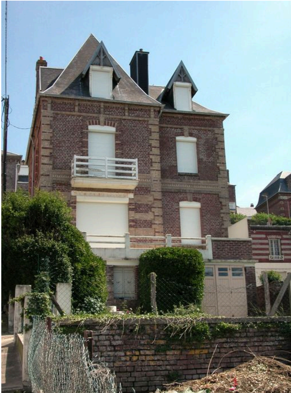
Elévation postérieure, orientée vers la mer.
