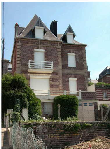
Élévation postérieure, orientée vers la mer. Phot. Elisabeth Justome IVR22_20048001497NUCA
