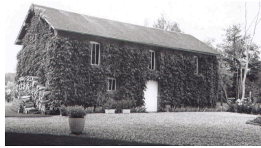
Ecurie et entrepôt de la minoterie. Phot. Thierry Lefébure IVR22_20026000693X
