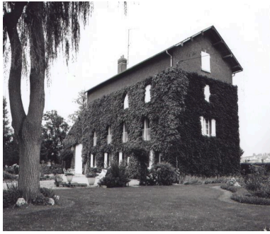
Vue d'ensemble sur cour du bâtiment de la minoterie. Phot. Thierry Lefébure IVR22_20026000694X
