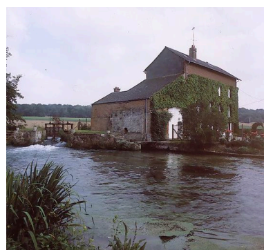
Vue générale. Phot. Thierry Lefebure IVR22_20026000950NUCA
