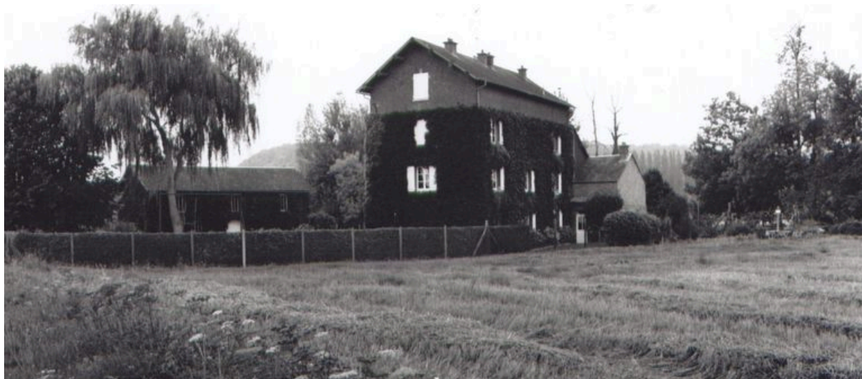
Vue d'ensemble de la minoterie de Monceaux.
