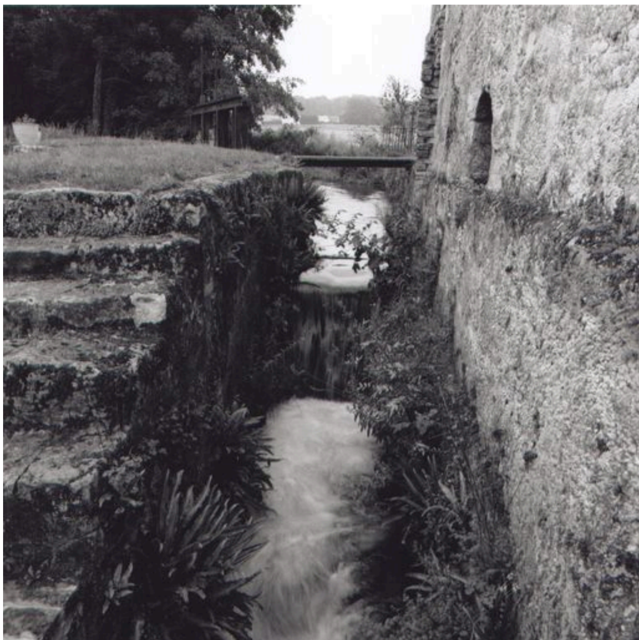
La coulerie maçonnée à l'emplacement de la roue disparue.
