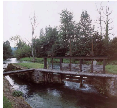
Le vannage de décharge. Phot. Thierry Lefébure IVR22_20026000946NUCA
