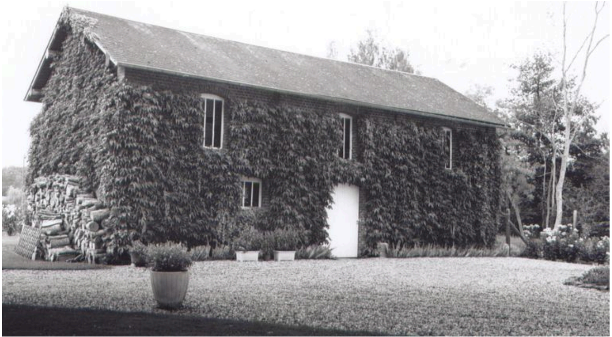
Ecurie et entrepôt de la minoterie.
