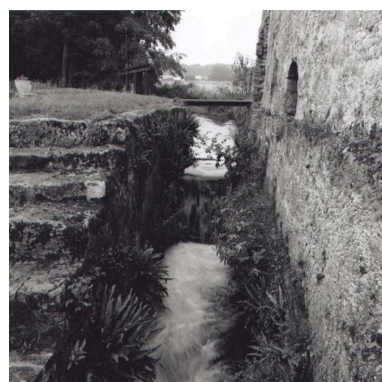
La coulerie maçonnée à l'emplacement de la roue disparue. Phot. Thierry Lefebure IVR22_20026000702X
