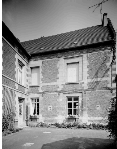
Élévation antérieure. Phot. Fabrice Charrondière IVR22_19866000095V
