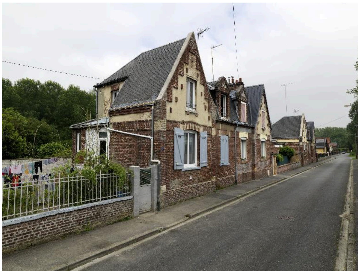
Ensemble de logements de contremaîtres ou employés de l'usine Maguin (1-11 rue Pierre-Semart).
