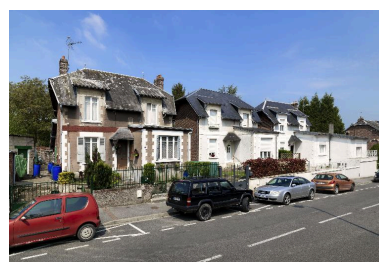
Ensemble de trois logements de contremaîtres de l'usine Maguin (74-78 rue Paul-Doumer). Phot. Thierry Lefébure IVR32_20160200040NUC2A
