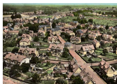
Vue aérienne de la cité jardin de la Grande Pièce. Carte postale, vers 1950 (coll. part.). Phot. Bertrand Fournier IVR32_20160205036NUCA
