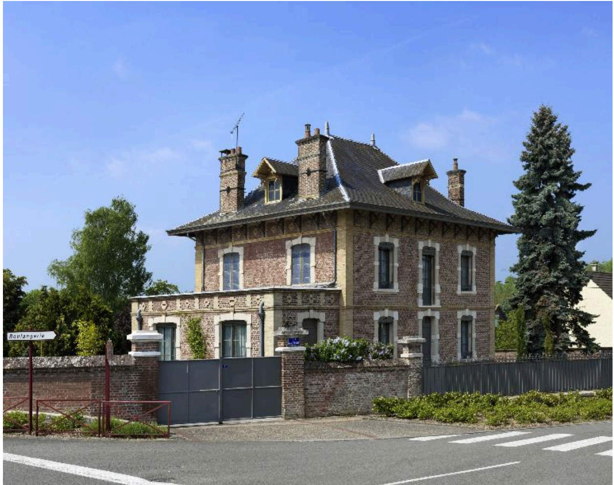
Ancienne maison de directeur de l'usine Maguin, construite en 1889 (1 rue Pierre-Timbaud).
