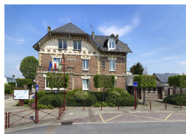
Ancienne demeure de l'industriel A. Maguin, devenue la mairie actuelle de la commune de Charmes. Phot. Thierry Lefébure IVR32_20160200056NUC2A
