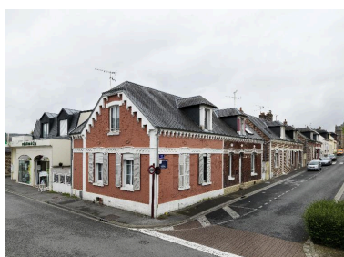
Vue d'ensemble de l'ancienne cité Maguin, rue Alfred Maguin. Phot. Thierry Lefébure IVR32_20160200104NUC2A
