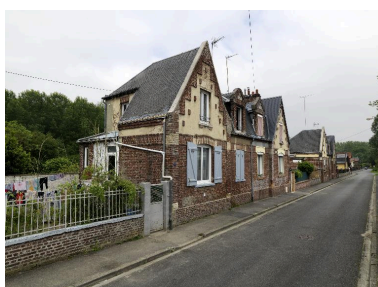
Ensemble de logements de contremaîtres ou employés de l'usine Maguin (1-11 rue Pierre-Semart). Phot. Thierry Lefébure IVR32_20160200113NUC2A
