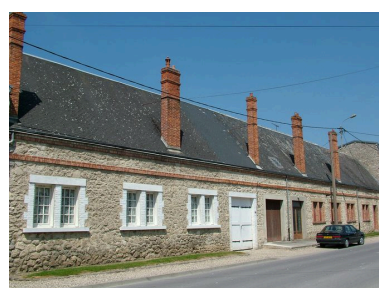
Vue d'une partie des maisons de la Grande Rue. Phot. Inès Guérin
