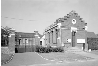
Vue du bâtiment oriental.
