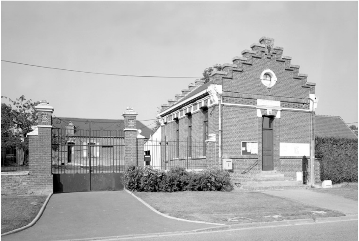
Vue du bâtiment oriental.
