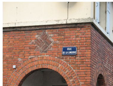
Détail de la mise en oeuvre des briques. Phot. Clarisse Lorieux IVR22_20076005220NUCA
