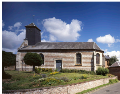
Vue extérieure de l'église, depuis le sud. Phot. Irwin Leullier IVR22_19988000836VA
