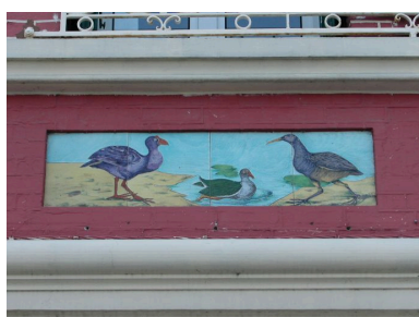
Détail des carreaux de céramique récents (premier panneau en partant de gauche). Phot. Elisabeth Justome IVR22_20058002894NUCA
