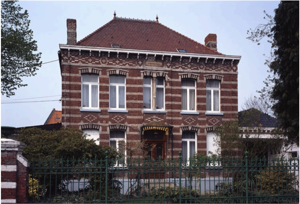
Vue générale de la maison d'un rouisseur de lin, rue S. Lannoy-Blin.
