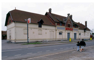
Vue d'ensemble sur rue en 1993. Phot. Patrick Glotain IVR22_19938000066ZA
