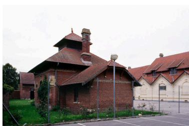
Vue des abattoirs de la Prévoyance, en 1993. Phot. Patrick Glotain IVR22_19938000069ZA
