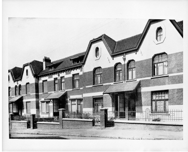
Elévation antérieure, entre 1927 et 1934. Extrait du recueil d'architecture d'Adolphe Danis (AP Dieux). Repro. Olivier Marlard IVR31_19925901794XB
