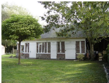
Vue des dépendances. Phot. Inès Guérin IVR22_20068005848NUCA
