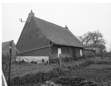
Façade postérieure depuis le jardin potager. Phot. Philippe Dapvril IVR31_20085901085X
