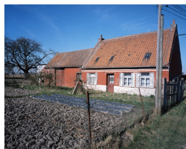
Vue de trois quarts depuis la rue de Guivarmez. Phot. Pierre Thibaut IVR31_20095901341VA
