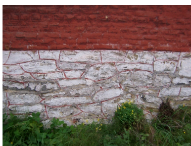
Détail du mur pignon sur rue : le soubassement en moellon de calcaire carbonifère (badigeonné de chaux). Phot. Cyril Cailleau IVR31_20055907424NUCA
