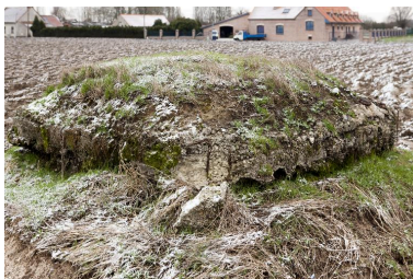
Vue vers le sud-ouest Phot. Jean-Marc Ramette IVR31_20145904157NUCA
