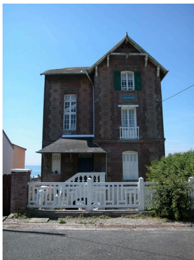
Façade d'entrée (sud-est). Phot. Elisabeth Justome IVR22_20058003282NUCA
