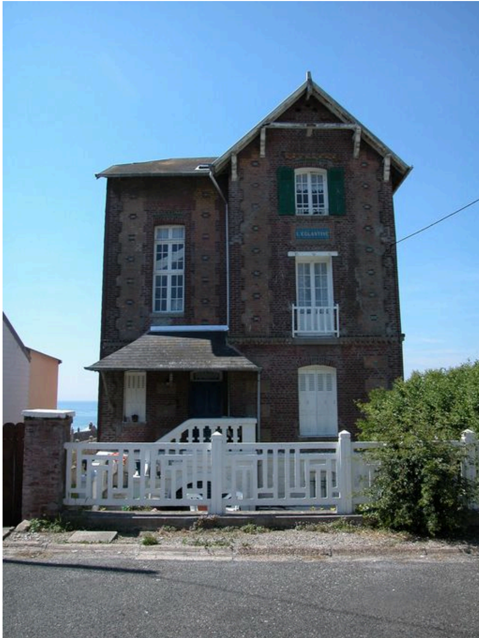
Façade d'entrée (sud-est).
