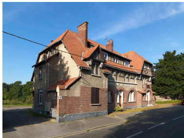
Vue de trois-quart. Phot. Thierry Lefébure IVR32_20218000276NUCA
