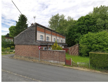
Maison à deux unités d'habitation (rue de la Famille-Venet) Phot. Thierry Lefébure IVR32_20170200191NUC2A
