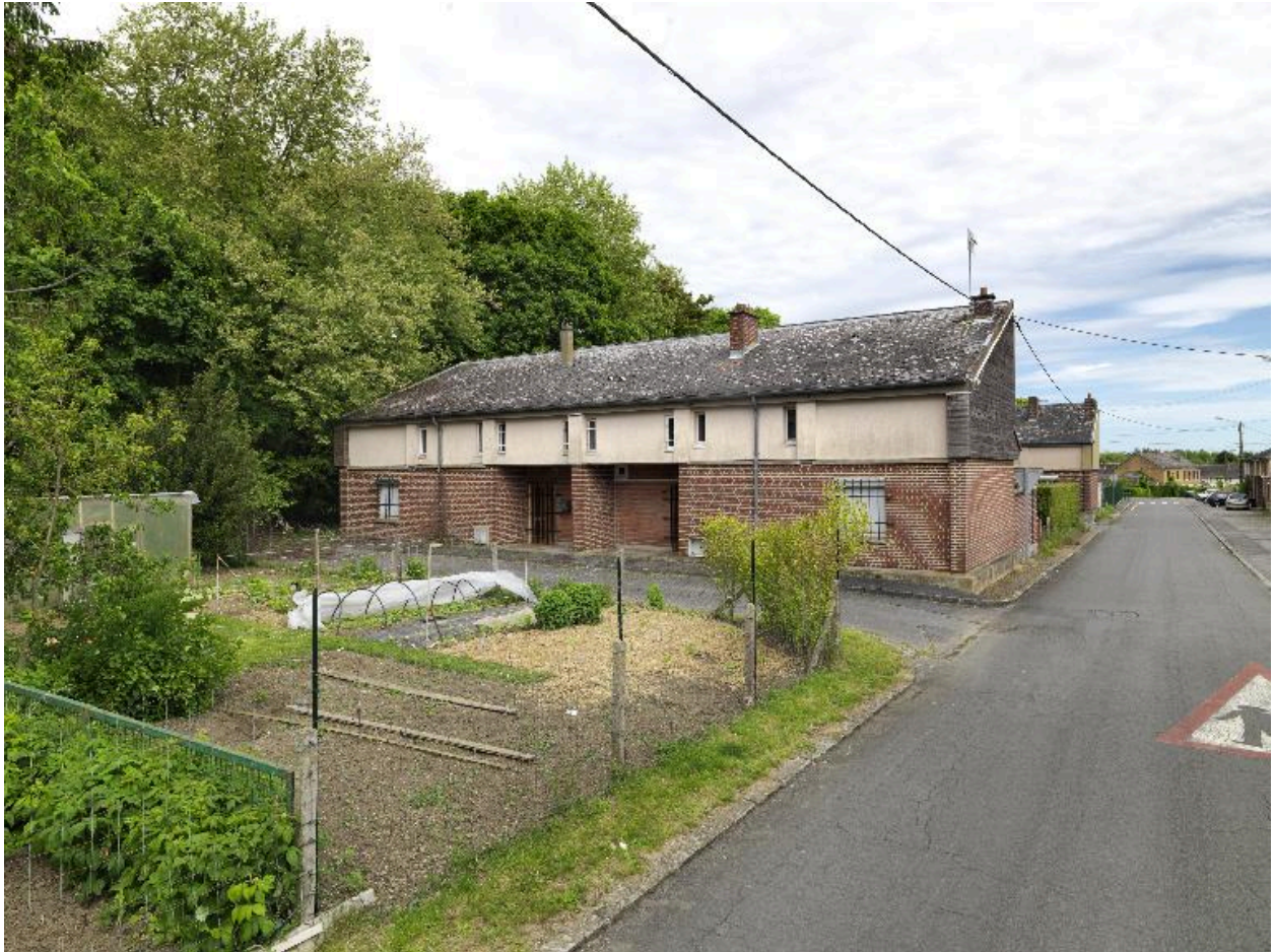
Maison à deux unités d'habitation, façade postérieure (rue de la Famille-Venet).
