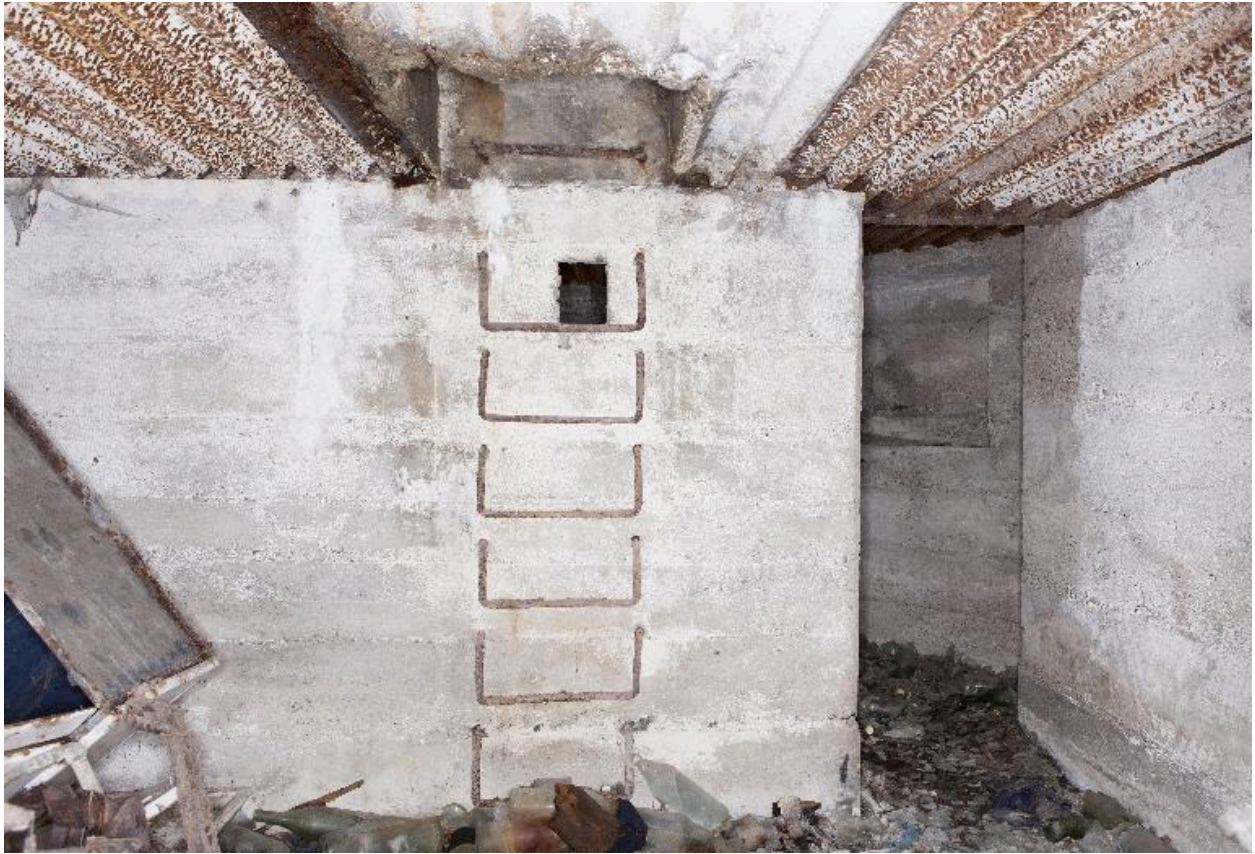
Casemate nord. Première salle rectangulaire avec, au centre, échelons métalliques menant à l'observatoire cuirassé
