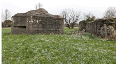
Vue vers l'est Phot. Jean-Marc Ramette IVR31_20145904251NUCA
