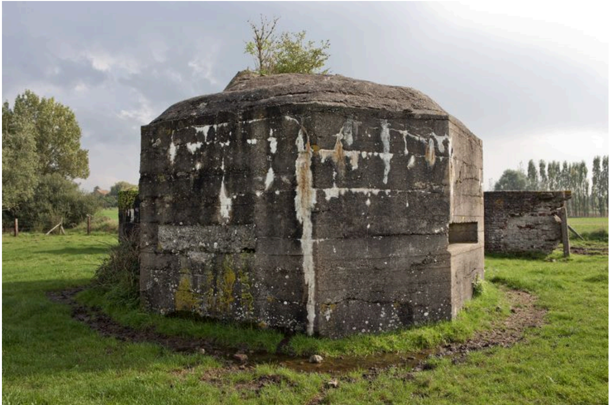
Casemate nord, vue vers le sud-sud-est. On aperçoit les deux embrasures de tir dont une a été condamnée
