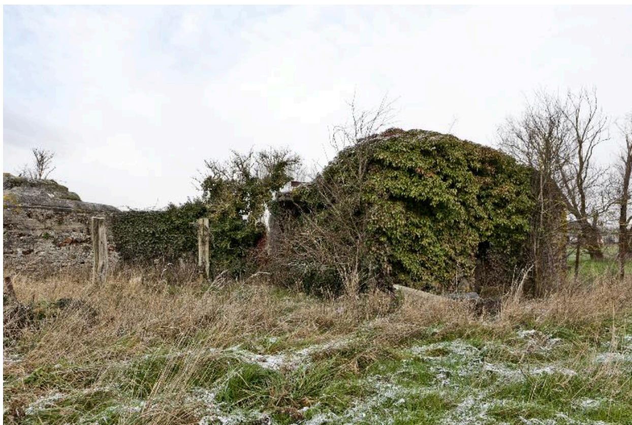
Casemate sud. Vue vers le nord.
