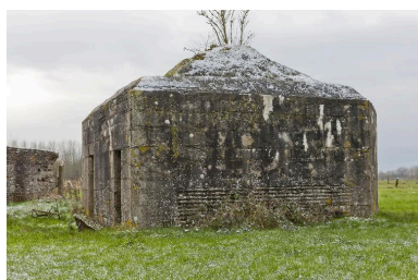
Casemate nord, vue vers le sud-ouest Phot. Jean-Marc Ramette IVR31_20145904257NUCA
