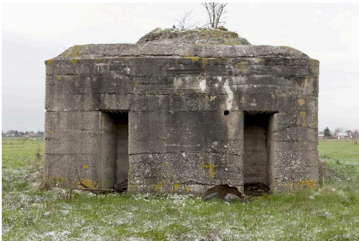
Casemate nord. Vue perpendiculaire à la face ouest. Les deux entrées.
