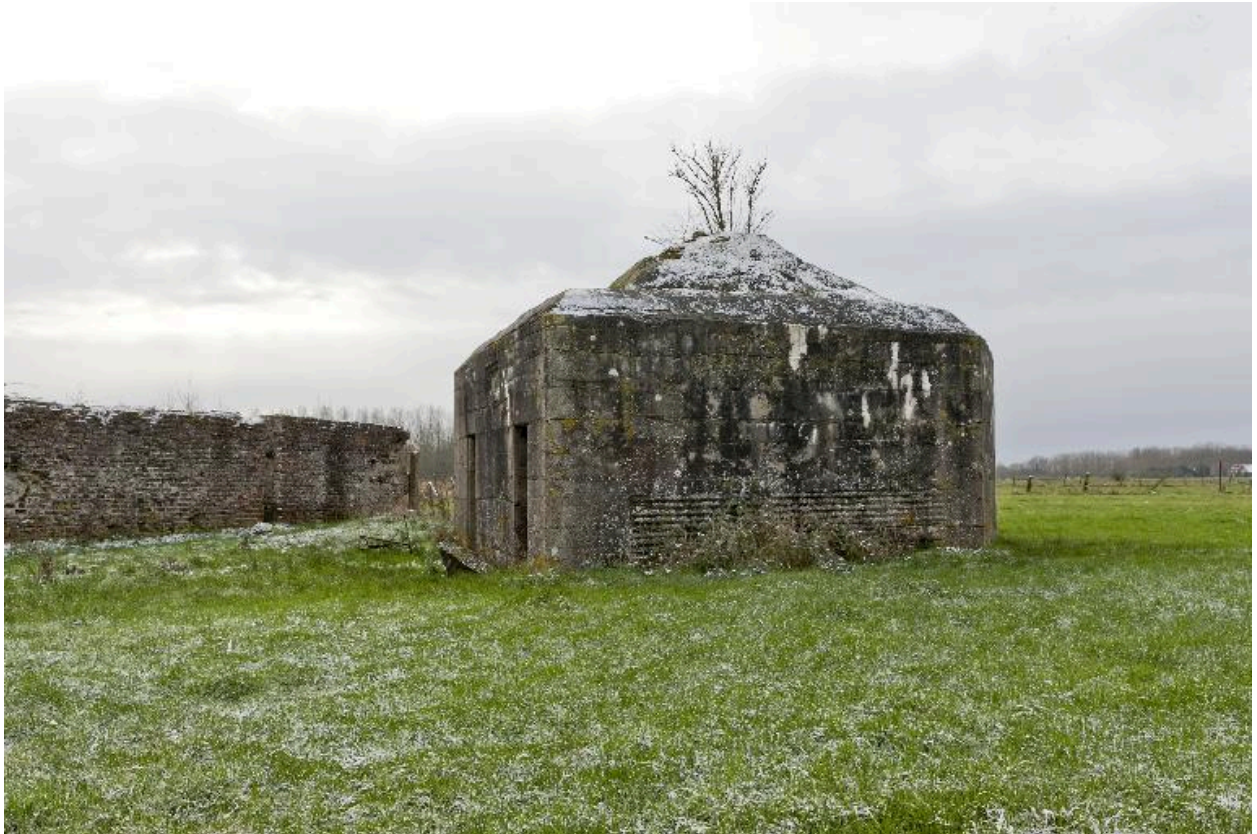
Vue générale, vers le sud-ouest
