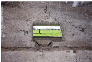
Casemate nord. Ouverture de tir ouest avec dispositif de blocage de la mitrailleuse. Phot. Pierre Thibaut IVR31_20155902012NUCA
