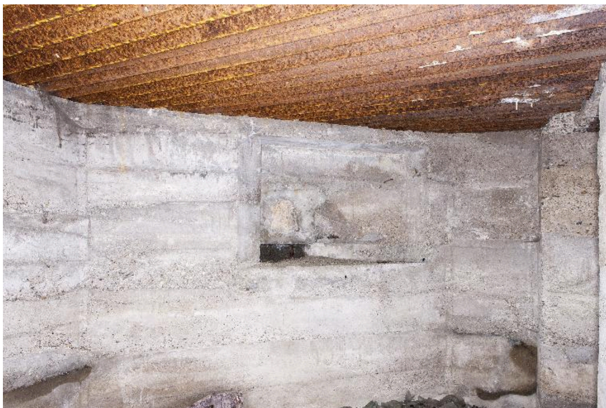
Catemate nord. Seconde salle. Ouverture de tir nord, condamnée
