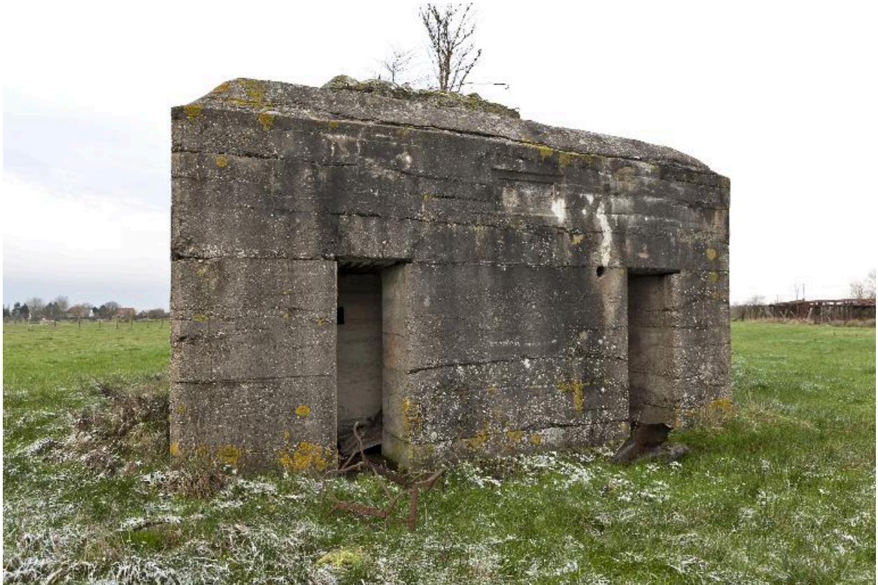
Casemate nord. Vue vers le nord.
