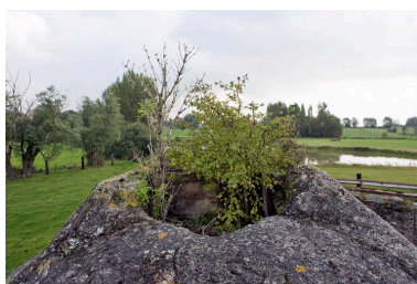
Casemate nord, sommet du dôme d'où émergeait l'observatoire cuirassé. Phot. Jean-Marc Ramette IVR31_20145904262NUCA
