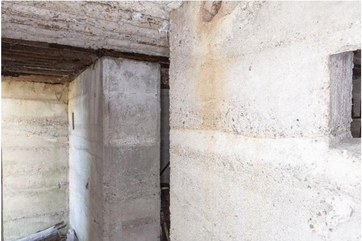
Vue intérieure, depuis une des deux entrées de la casemate nord
