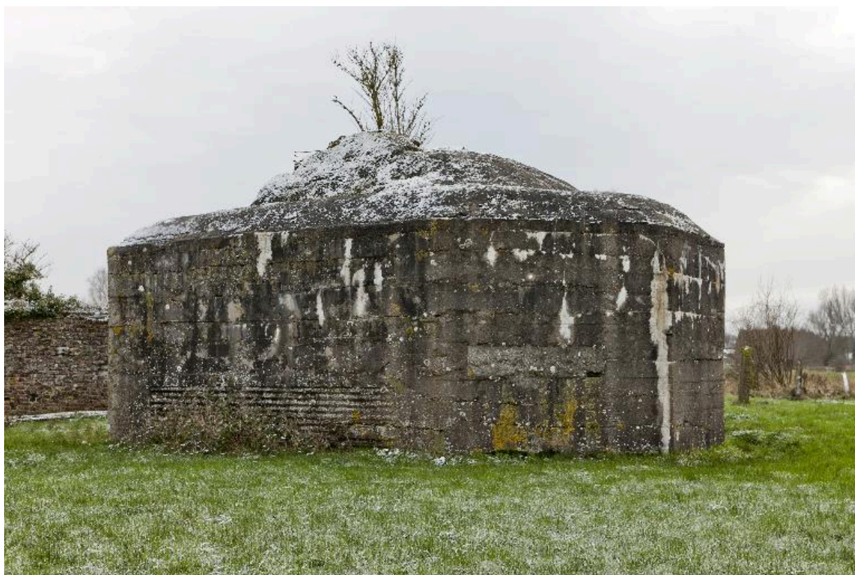
Casemate nord, vers le sud
