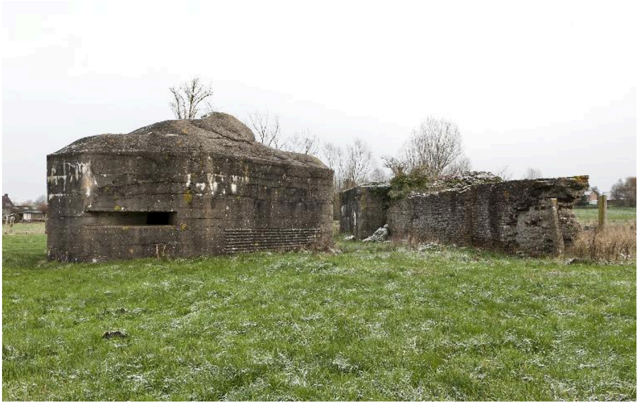
Vue vers le sud-est
