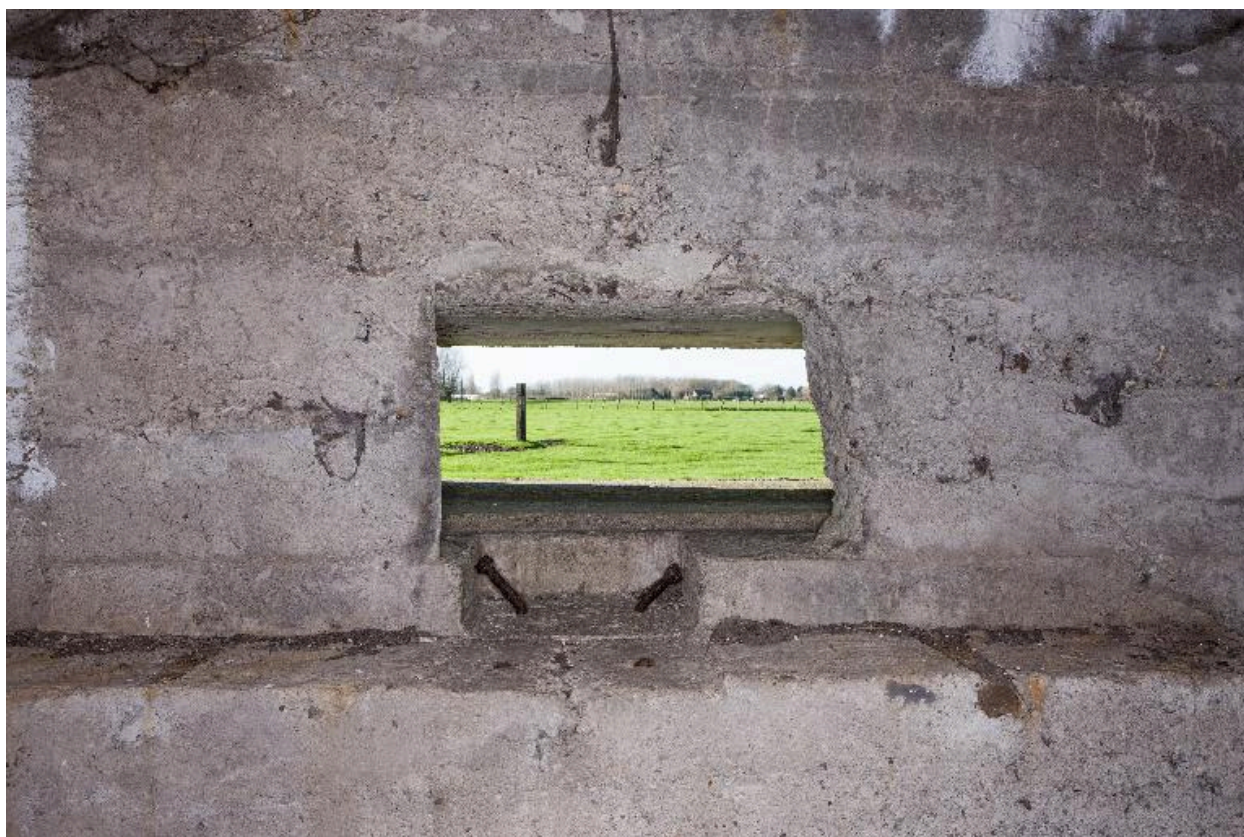
Casemate nord. Ouverture de tir ouest avec dispositif de blocage de la mitrailleuse.
