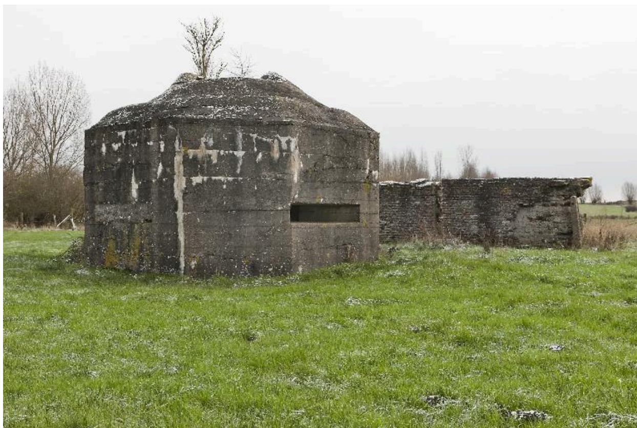
Casemate nord, vue vers le sud-sud-est
